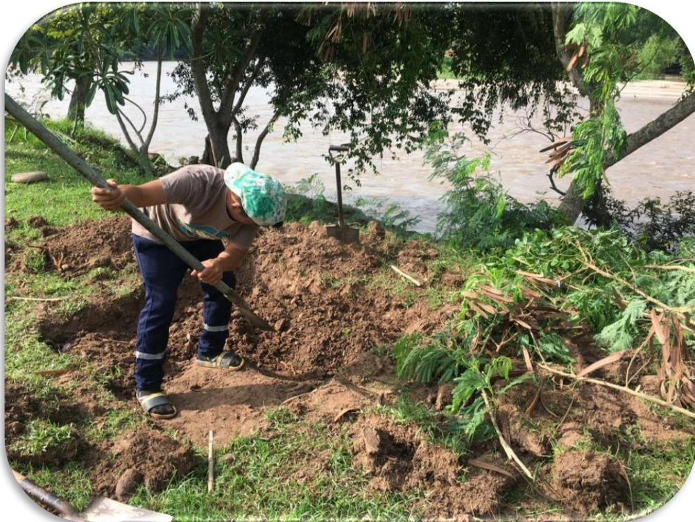
Figura 3: Excavación de calicata N° 01
