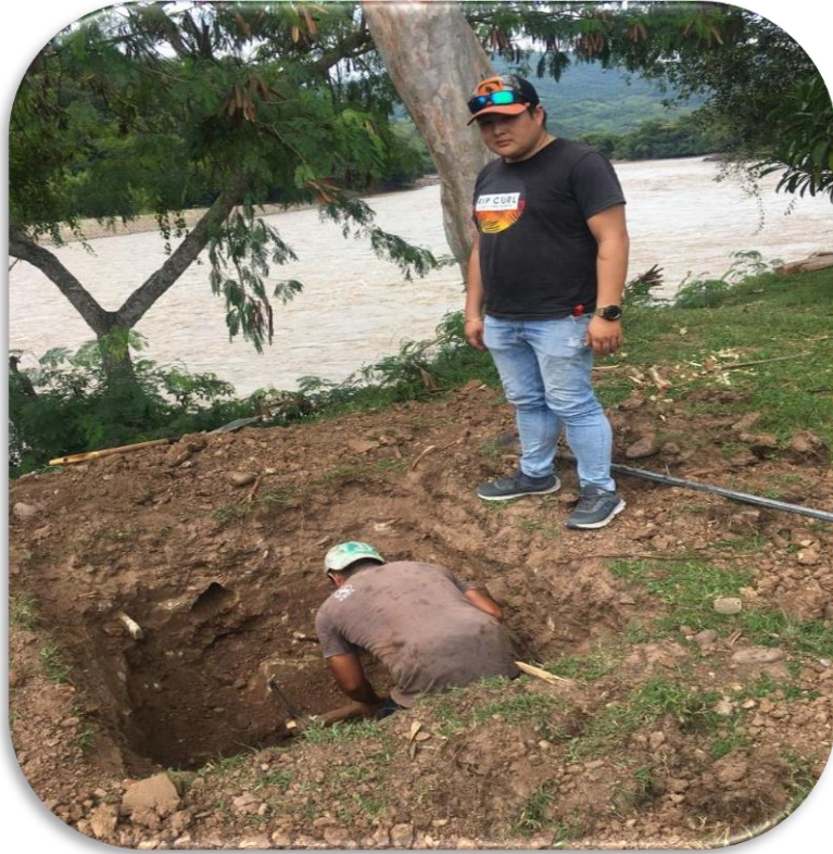
Figura 4: Excavación de calicata N° 02
