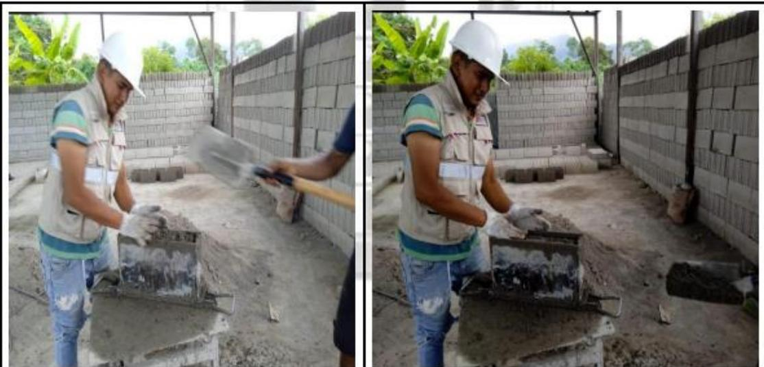
Fotos nº 09-10: En las imágenes podemos observar al personal realizando moldeo de los bloques de concreto.
