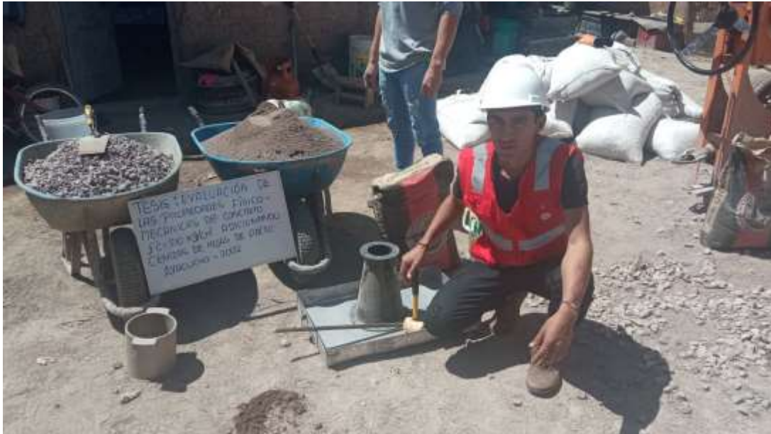
Preparación de agregado fino y grueso.
