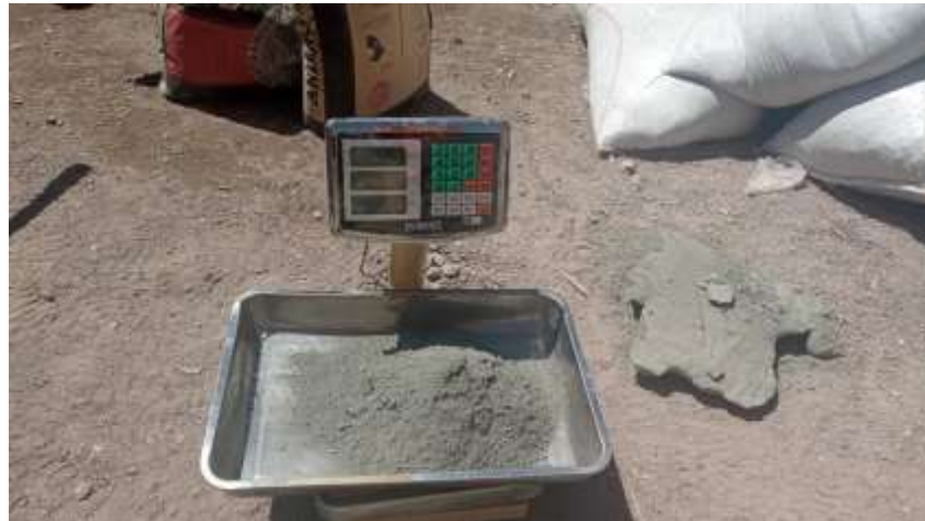
Figura 26. Pesado de cemento.
