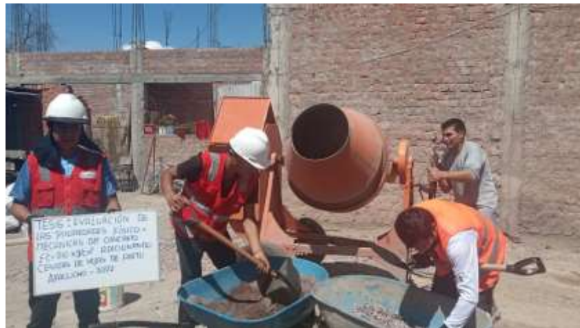
Figura 27. Elaboración de muestras de concreto.
