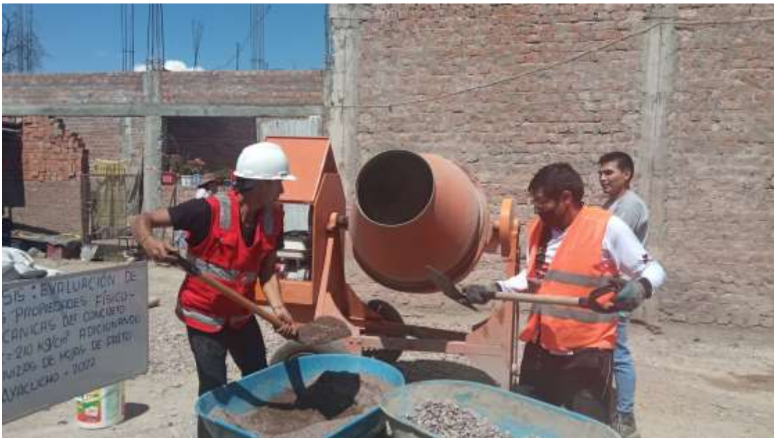
Preparación de muestras de concreto.
