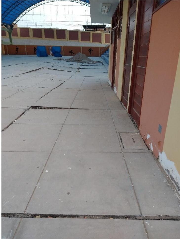
*Figura 14:* Se puede advertir que el área en la que convergen asentamientos de hasta 48, 30.5 y 35.5 centímetros, respectivamente, en la gradería de la losa de concreto, servicios higiénicos y patio de acceso.
