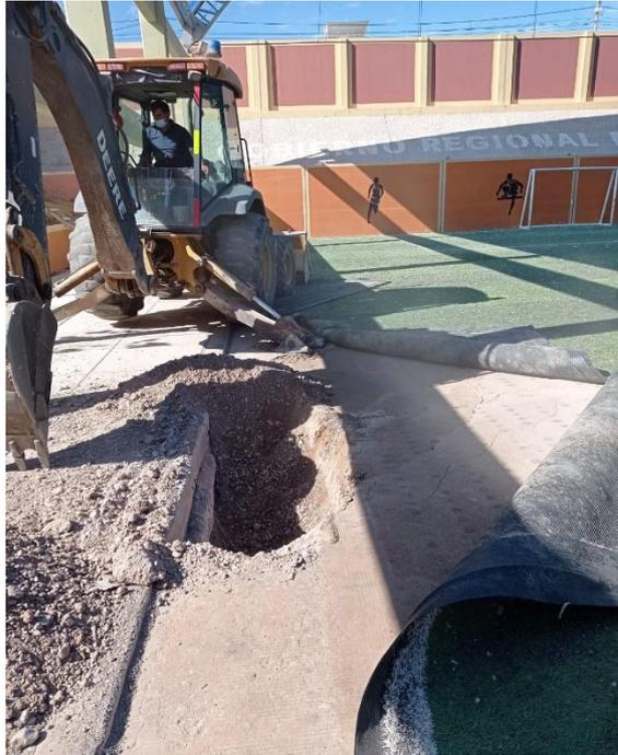
*Figura 55:* Se realizó la apertura de la séptima calicata la cual se ubicó entre la cancha de fútbol, vereda y columna del pórtico
