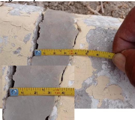
*Figura 30:* Se advierte que la junta de separación sísmica hay un espaciamiento de 3.8 centímetros en la séptima junta.
