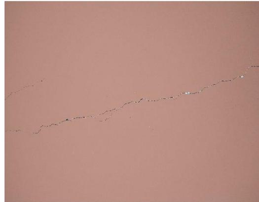
*Figura 20:* Se aprecia fisuras en el sector de los servicios higiénicos.
