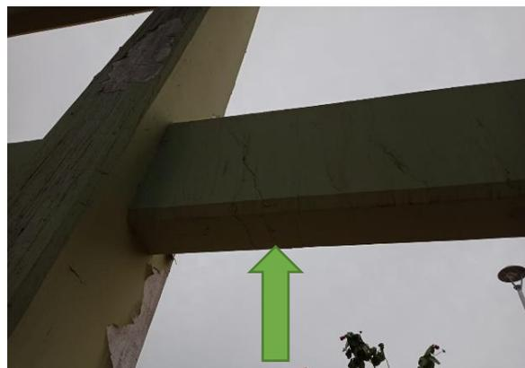
*Figura 27:* Se advierte la presencia de fisuras en el pórtico que soporta la cobertura liviana en la cuarta viga.
