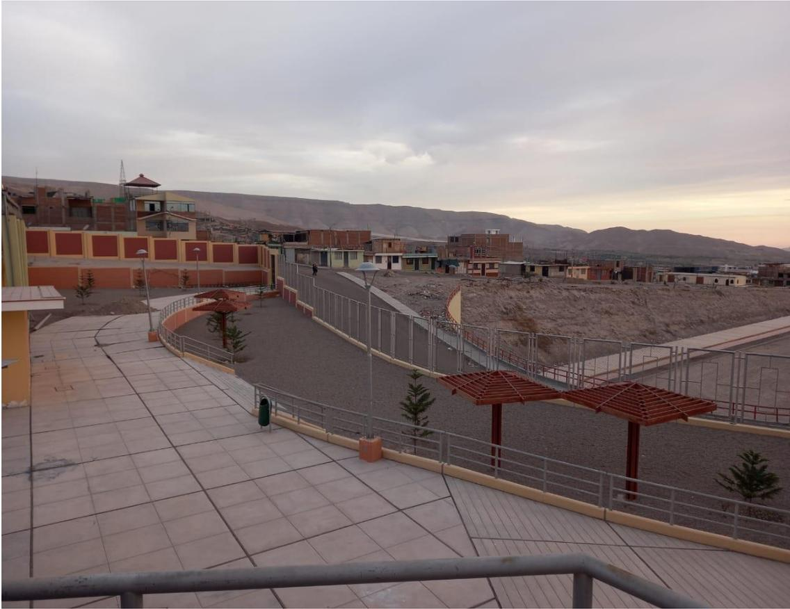
*Figura 13:* Se puede advertir que la plataforma del área ocupada de la I.E. se encuentra construida sobre una quebrada, existiendo un desnivel de aproximadamente 15 metros.
