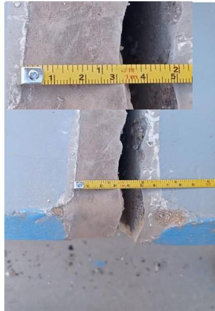
*Figura 18:* Se aprecia la separación de la junta sísmica
