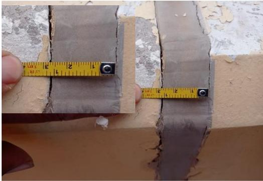
*Figura 32:* Se advierte que la junta de separación sísmica hay un espaciamiento de 2.7 centímetros en la novena junta.
