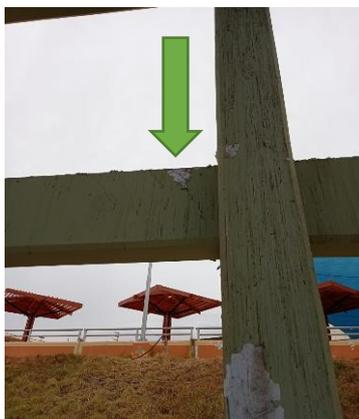
*Figura 26:* Se advierte que en el pórtico que soporta la cobertura liviana en la tercera viga hay presencia de fisuras.
