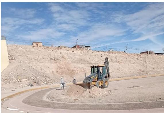
*Figura 49:* Se realizó la apertura de la cuarta calicata la cual se ubicó al costado del canal de Pasto Grande
