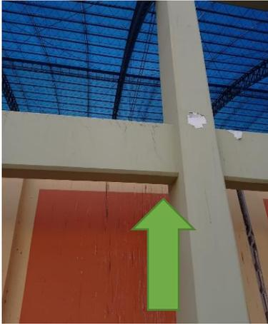
*Figura 22:* Se advierte que el pórtico que soporta la cobertura liviana en la segunda viga hay presencia de fisuras.
