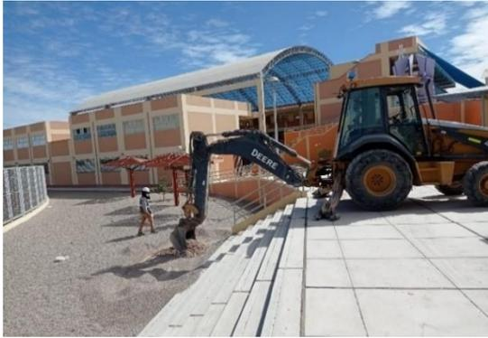
*Figura 45:* Se realizó la apertura de la segunda calicata la cual se ubicó la gradería y la zona de muro de contención adyacente al canal Pasto Grande
