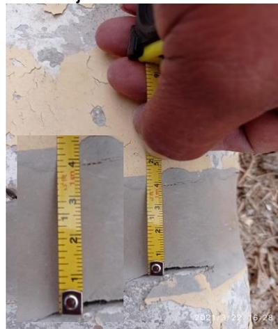
*Figura 31:* Se advierte que la junta de separación sísmica hay un espaciamiento de 3.9 centímetros en la octava junta.
