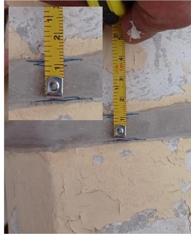
*Figura 33:* Se advierte que la junta de separación sísmica hay un aplastamiento de 1.1 centímetros en la sexta junta.
