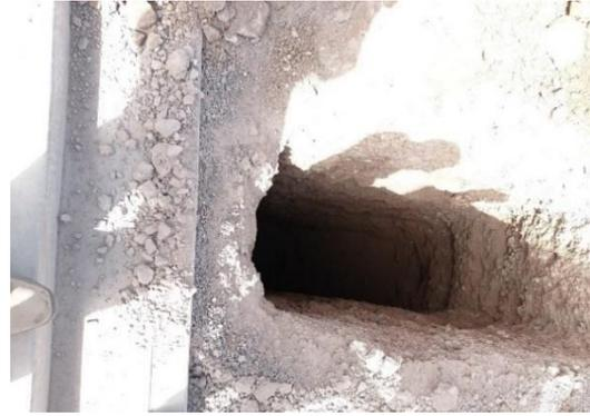
*Figura 46:* Se advierte que dicha calicata tiene una profundidad de 4.50 metros.
