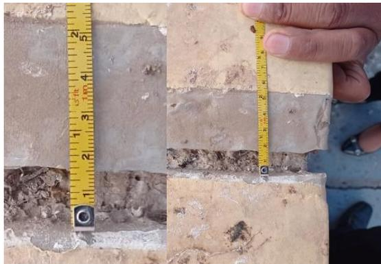
*Figura 16:* Se advierte la separación de la junta de separación sísmica
