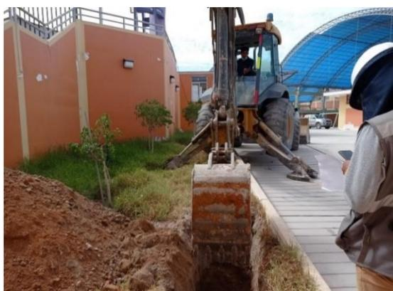
*Figura 43:* Se realizó la apertura de la primera calicata la cual se ubicó en la jardinera adyacente al nivel secundario.
