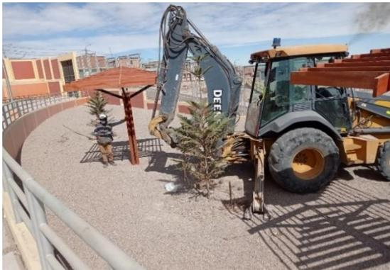
*Figura 47:* Se realizó la apertura de la tercera calicata la cual se ubicó la gradería y la zona de muro de contención adyacente al canal Pasto Grande.
