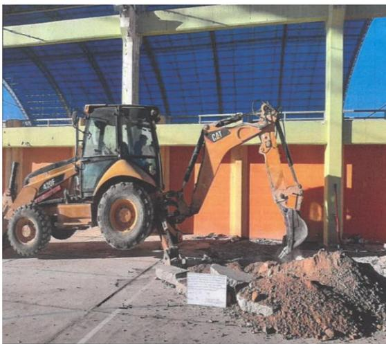
*Figura 57:* Se realizó la apertura de la octava calicata la cual se ubicó en el pórtico central la cual soporta la cobertura de policarbonato
