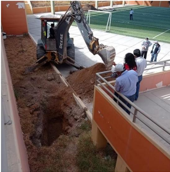
*Figura 51:* Se realizó la apertura de la quinta calicata la cual se ubicó jardinería adyacente al nivel primario
