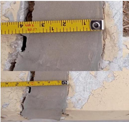
*Figura 28:* Se advierte que la junta de separación sísmica hay un espaciamiento de 3.9 centímetros en la segunda junta.
