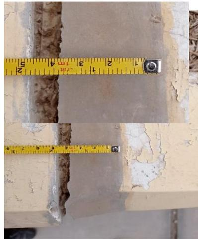
*Figura 29:* Se advierte que la junta de separación sísmica hay un espaciamiento de 4.6 centímetros en la tercera junta.
