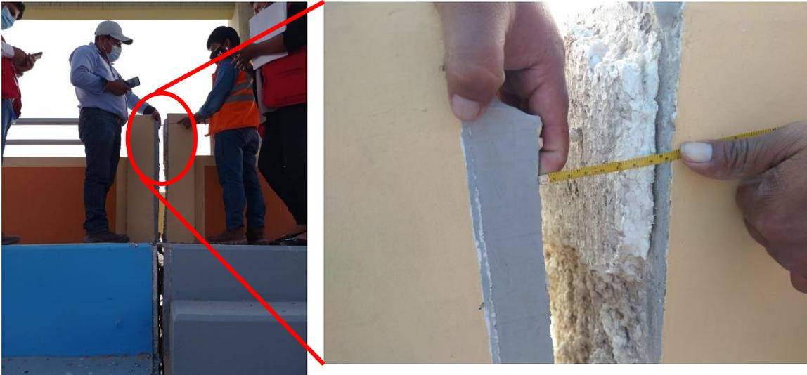
*Figura 15:* Se puede apreciar la separación de la junta de separación sísmica es de 11 centímetros.
