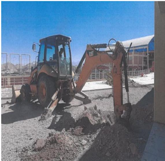
*Figura 61:* Se realizó la apertura de la décima calicata la cual se ubicó la zapata del pórtico posterior a la gradería de la losa de concreto.
