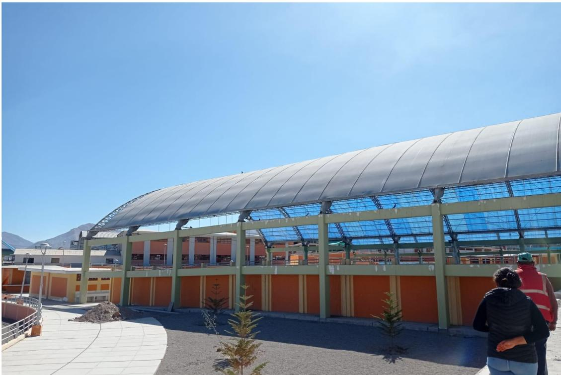
*Figura 36:* Se aprecia el asentamiento a la izquierda del pórtico que soporta la cobertura liviana.
