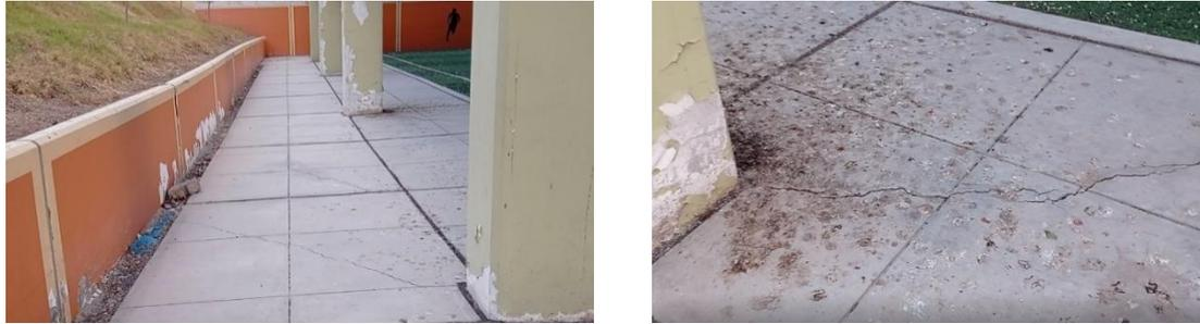
*Figura 25:* Se advierte fisuras entre la segunda y quinta columna del pórtico que soporta la cobertura de policarbonato.
