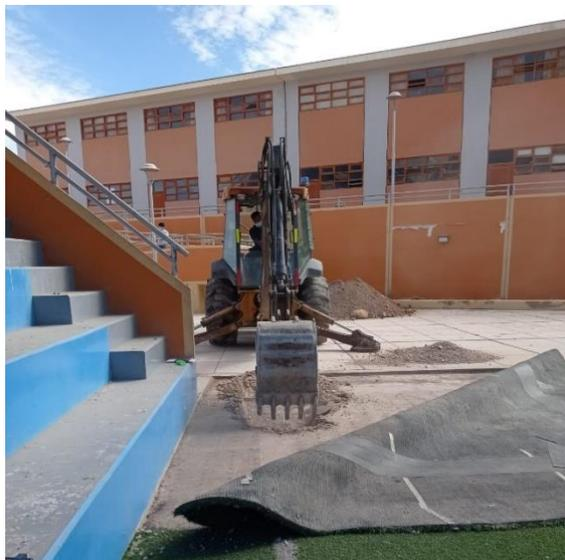
*Figura 53:* Se realizó la apertura de la sexta calicata la cual se ubicó en el cimiento de la gradería de la cancha de fútbol colindante con el patio de concreto
