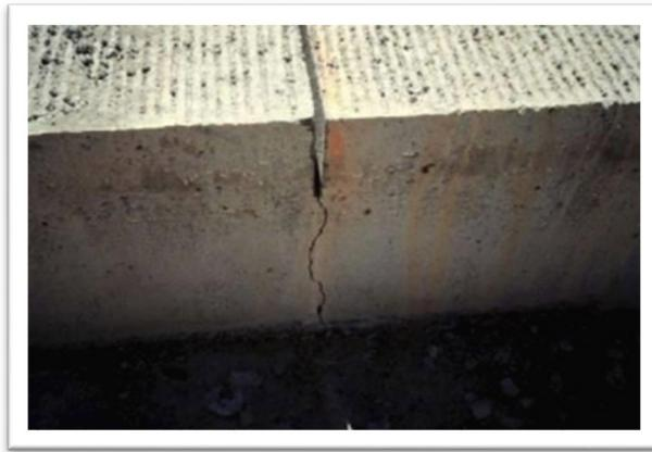
Figura 2: Grieta generada por la forma de los agregados
