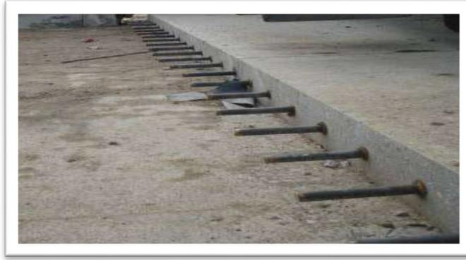
Figura 3: Colocado de los pasadores para las juntas transversales
