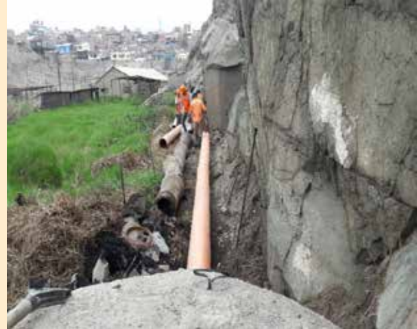
Renovación de 09 tramos Sub Emisor Sector Patio Del Ferrocarril - Mollendo
