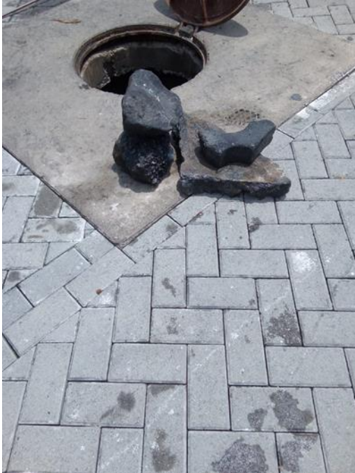
Mantenimiento de Redes de Alcantarillado
