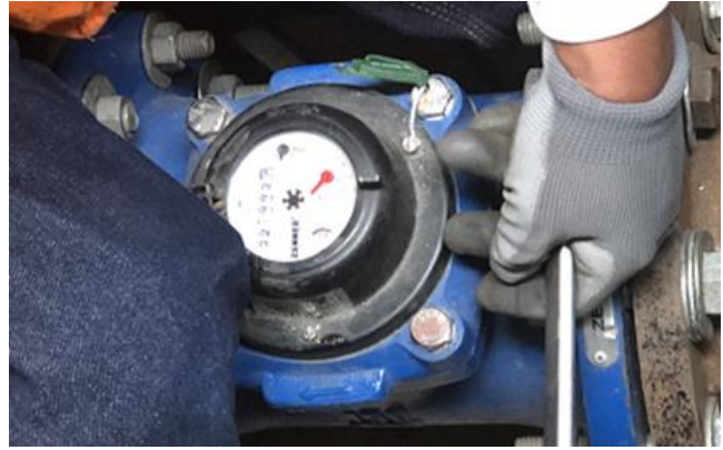
Instalación de macromedidor de 6" de diámetro
