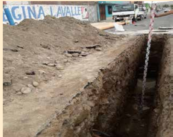
Renovación Red de Desague 38 m.l. Esquina de Malecón Islay con San Pedro – Matarani
