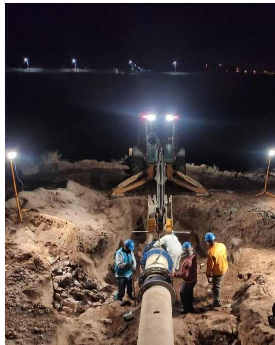
RTC en la línea de conducción de 700 mm. al R11 de concreto reforzado
