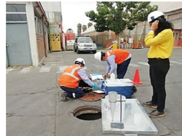
Inspección caja de registro externo
