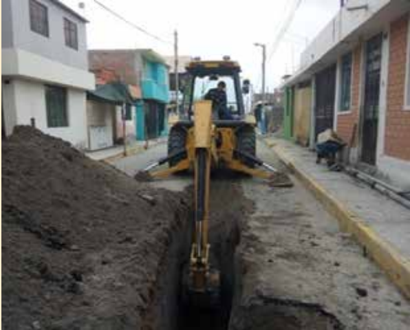
Renovación de 03 tramos Red desagüe calle Fátima e Islay – La Curva
