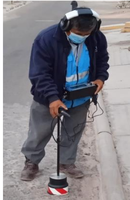
Uso de equipos para ubicacion de fuga no visible en línea de conducción del N24
