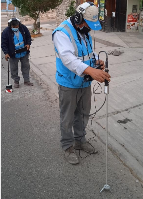
Uso de equipos para ubicacion de fuga no visible en línea de conducción del N-24
