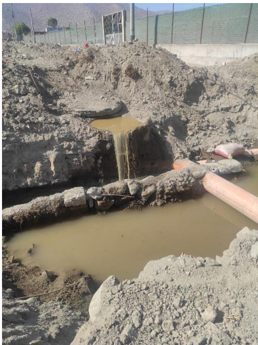
Mantenimiento de Redes de Alcantarillado
