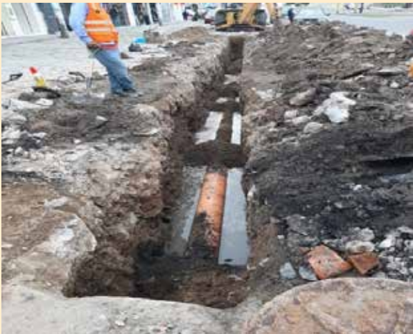
Renovación de 01 Tramo Red De Desagüe Calle Panamericana - Mollendo
