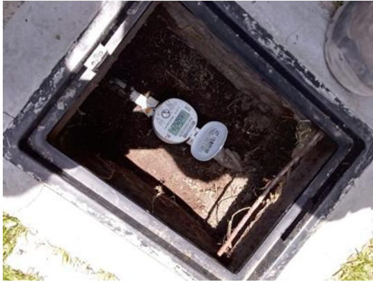
Trabajos para prueba piloto con medidores ultrasónicos
