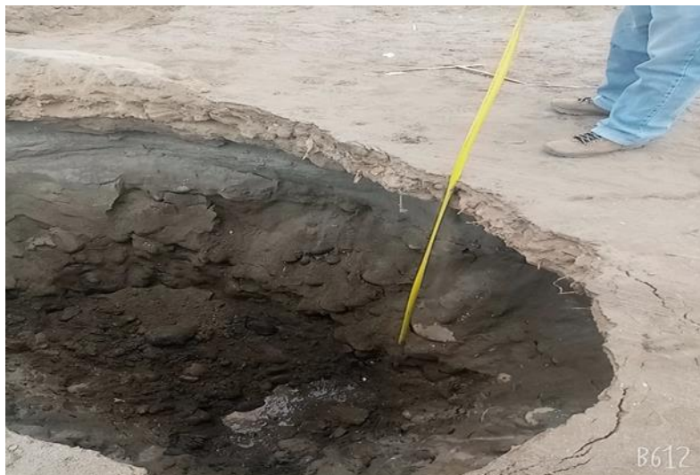
Figura 28 Ubicación de la calicata N °3, en coordenadas. 371399.70 E y 8511174.50 N.
