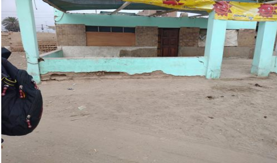
Figura 23 Vivienda de la encuesta N°26, presenta como material predominante la categoría “adobe”, misma que muestra un estado de conservación no adecuado, Presenta un deterioro que tal hace presumir su colapso
