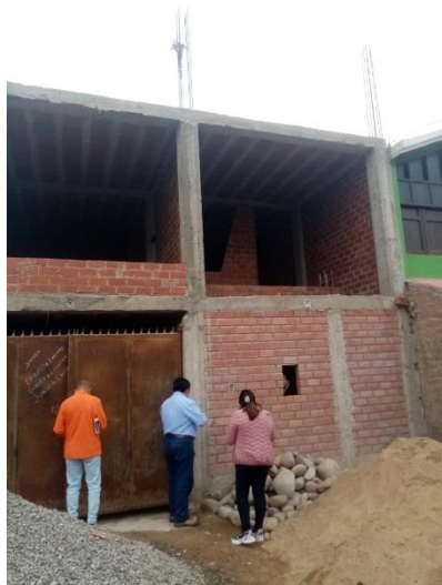
Figura 34 Realización de prueba de esclerómetro en viga, como P 3.
