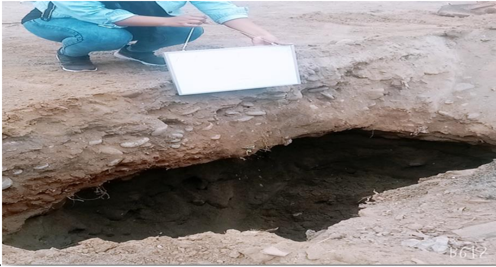
Figura 27 Ubicación de la calicata N °2, en coordenadas. 371285.40 E y 8511079.90 N.
