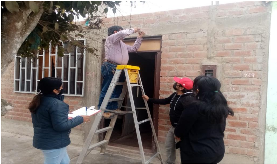
Figura 33 Realización de prueba de esclerómetro en viga, como P 3.
