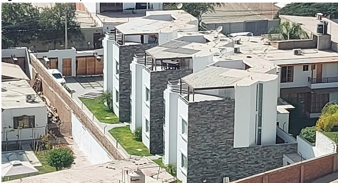
Figura 38: Edificios Departamentales Los Girasoles.
