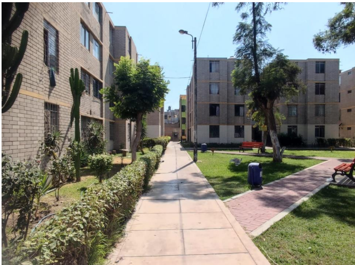
Figura 27: Conjunto habitacional José Matías Manzanilla.
