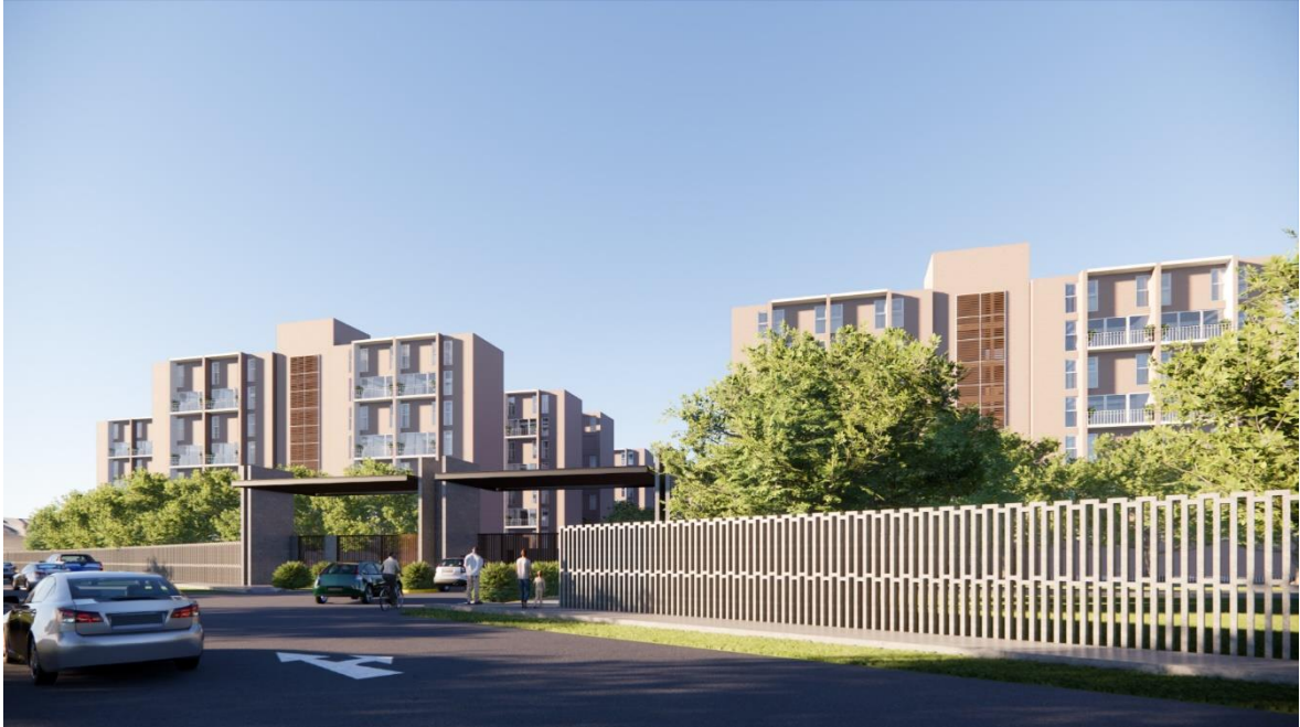
Vista “Fachada principal”
