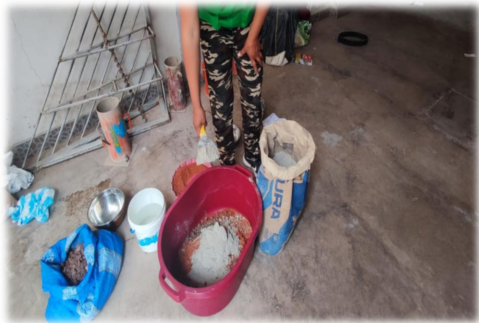
FOTO N°07 LA Dotación de cemento según dosificación
