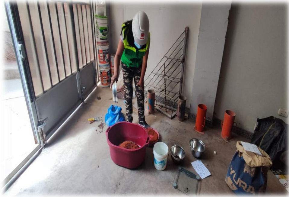
FOTO N° 06 Mezclado de agregados según dosificación
