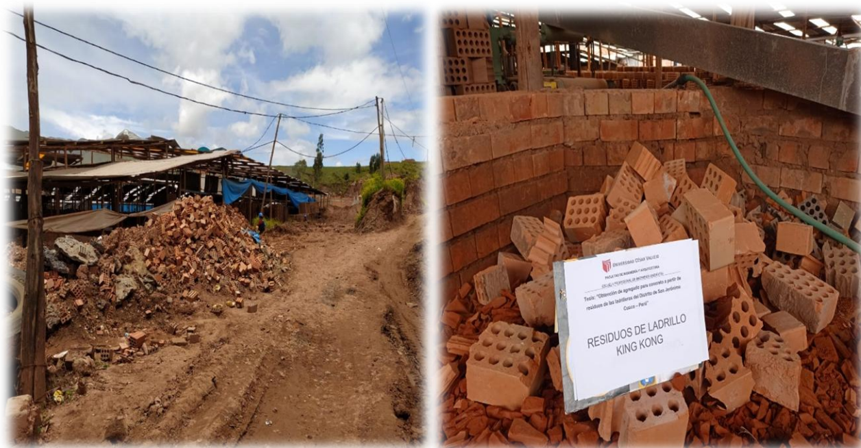
FOTO N° 01 Residuos de ladrillos
