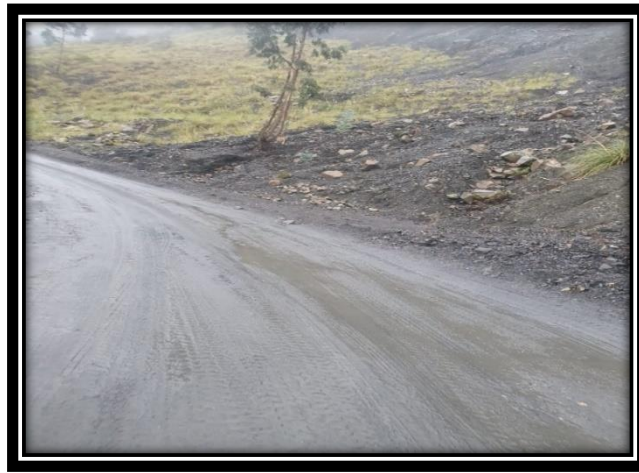
Figura 1: Vista carretera 01 Fuente: Propia
