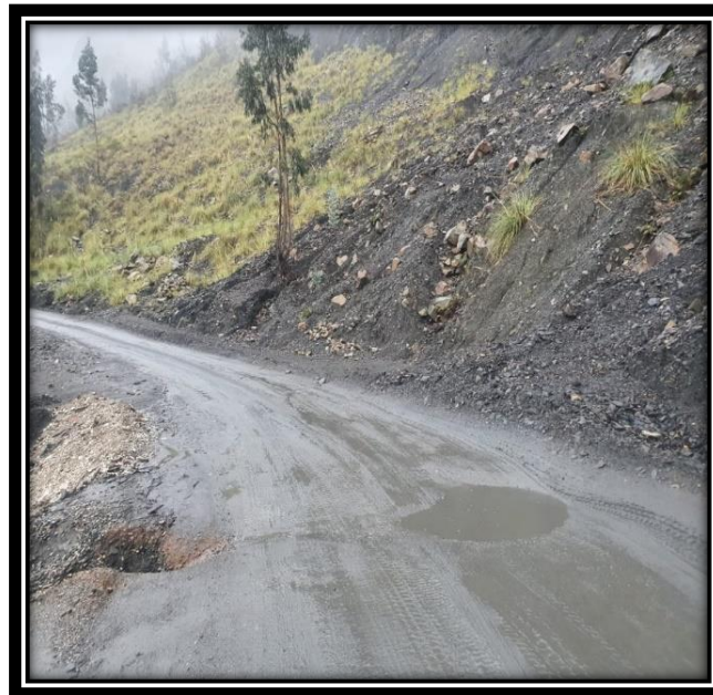
Figura 2: Vista carretera 02 Fuente: Propia
