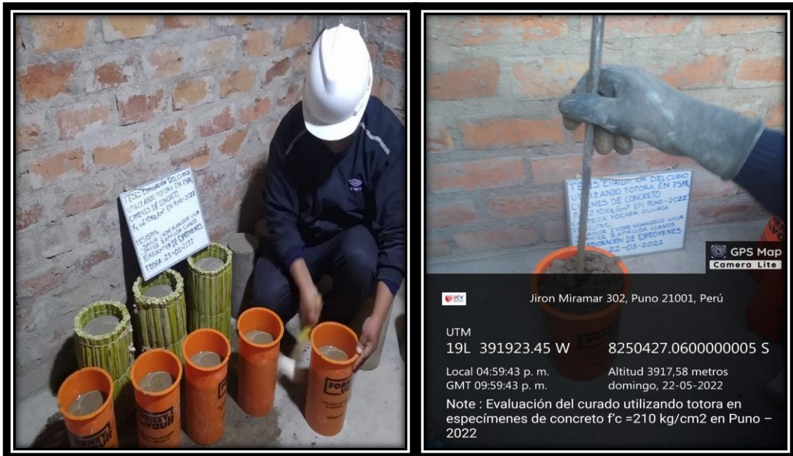
Figura 11. Varillado y vibrado del concreto
