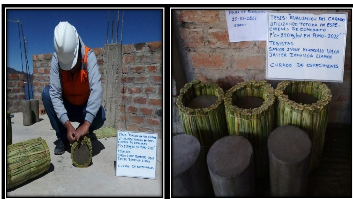
Figura 14. Cubrimiento del concreto con totora para el curado
