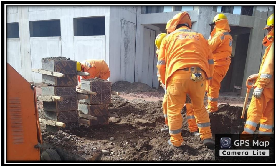
Abastecimiento de materiales para la elaboración de concreto según diseño de mezcla.
