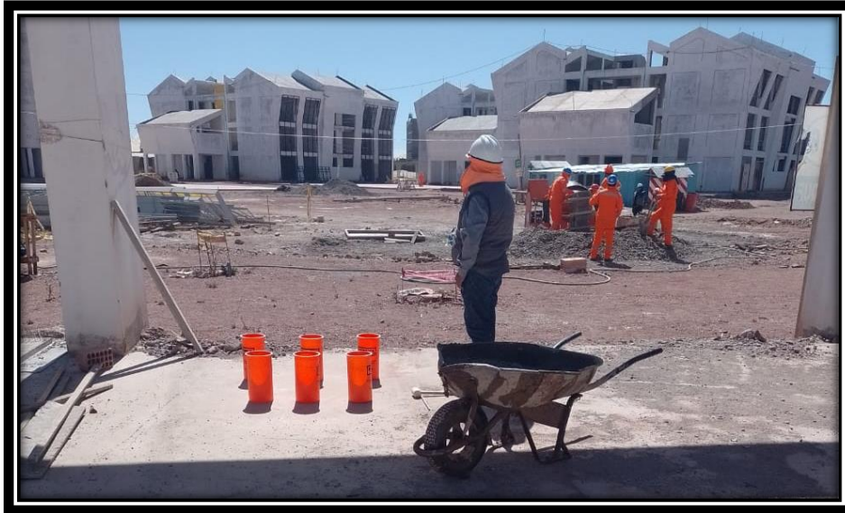
Elaboración de especímenes de concreto.
