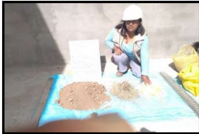
Figura 34. Dosificación de mezcla
