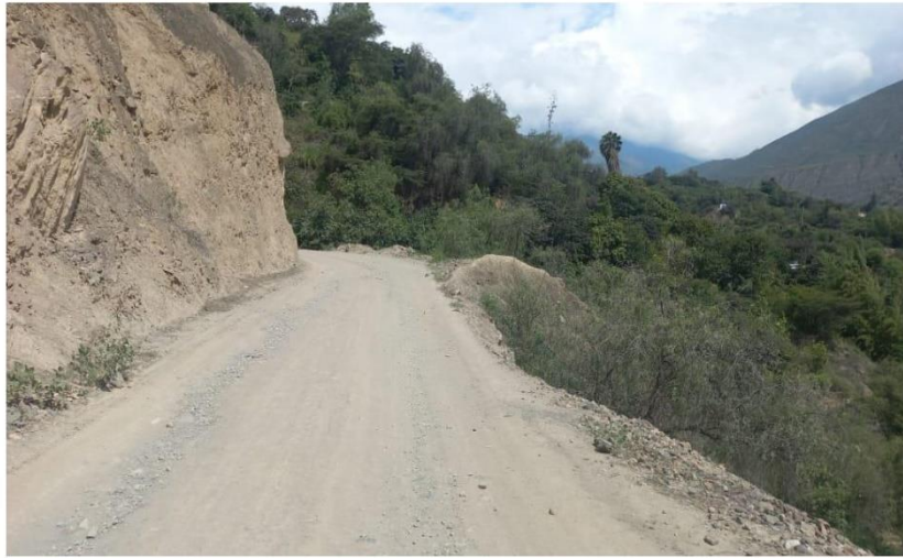
VISTA PANORÁMICA DE LA CALICATA C-2 DONDE SE PROYECTO LA LINEA DE CONDUCCION - CASERIO QUIHUAY
