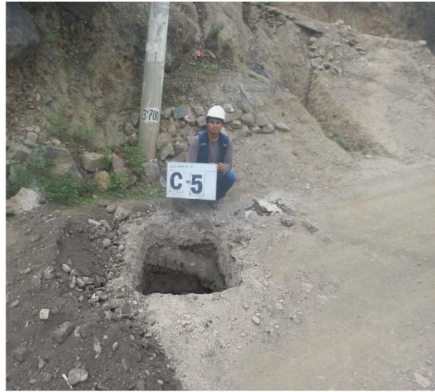
VISTA PANORAMICA DE LA CALICATA C-5 DONDE SE PROYECTO LA RED DE DISTRIBUCION Y RED COLECTORA - CASERIO QUIHUAY
