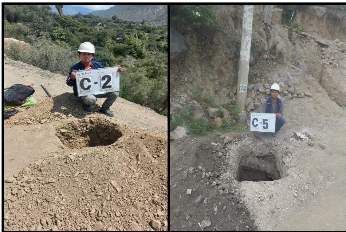
Figura 21, Figura 22, Fotografía realizando calicata para el posterior estudio de suelo.
