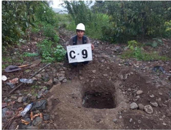
VISTA PANORAMICA DE LA CALICATA C-9 DONDE SE PROYECTO EL TANQUE SEPTICO - CASERIO QUIHUAY
