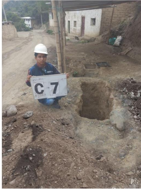
VISTA PANORAMICA DE LA CALICATA C-7 DONDE SE PROYECTA LA RED DE DISTRIBUCION Y RED COLECTORA - CASERIO QUIHUAY
