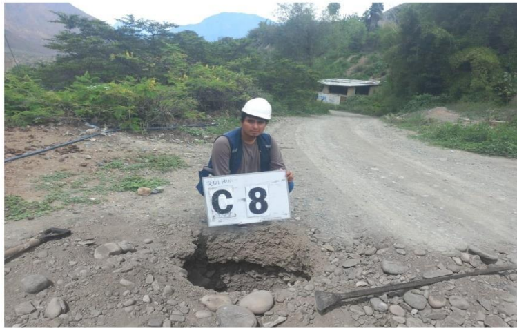
VISTA PANORAMICA DE LA CALICATA C-8 DONDE SE PROYECTA LA RED DE DISTRIBUCION Y RED COLECTORA - CASERIO QUIHUAY
