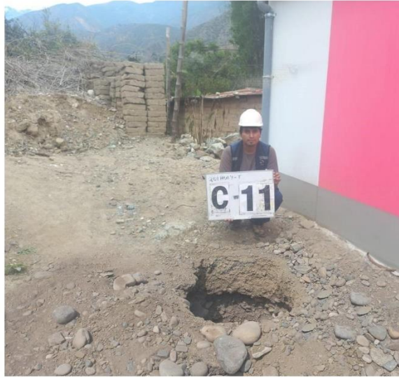
VISTA PANORAMICA DE LA CALICATA C-11 DONDE SE PROYECTO LA RED DE DISTRIBUCION Y RED COLECTORA - CASERIO QUIHUAY
