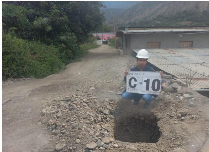
VISTA PANORAMICA DE LA CALICATA DONDE SE PROYECTO LA RED DE DISTRIBUCION Y RED COLECTORA C-10 CASERIO QUIHUAY
