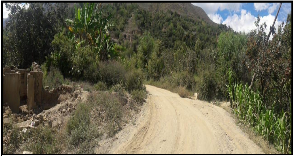
Figura 14: Fotografía donde se proyectó la línea de aducción del Caserío de Quihuay
