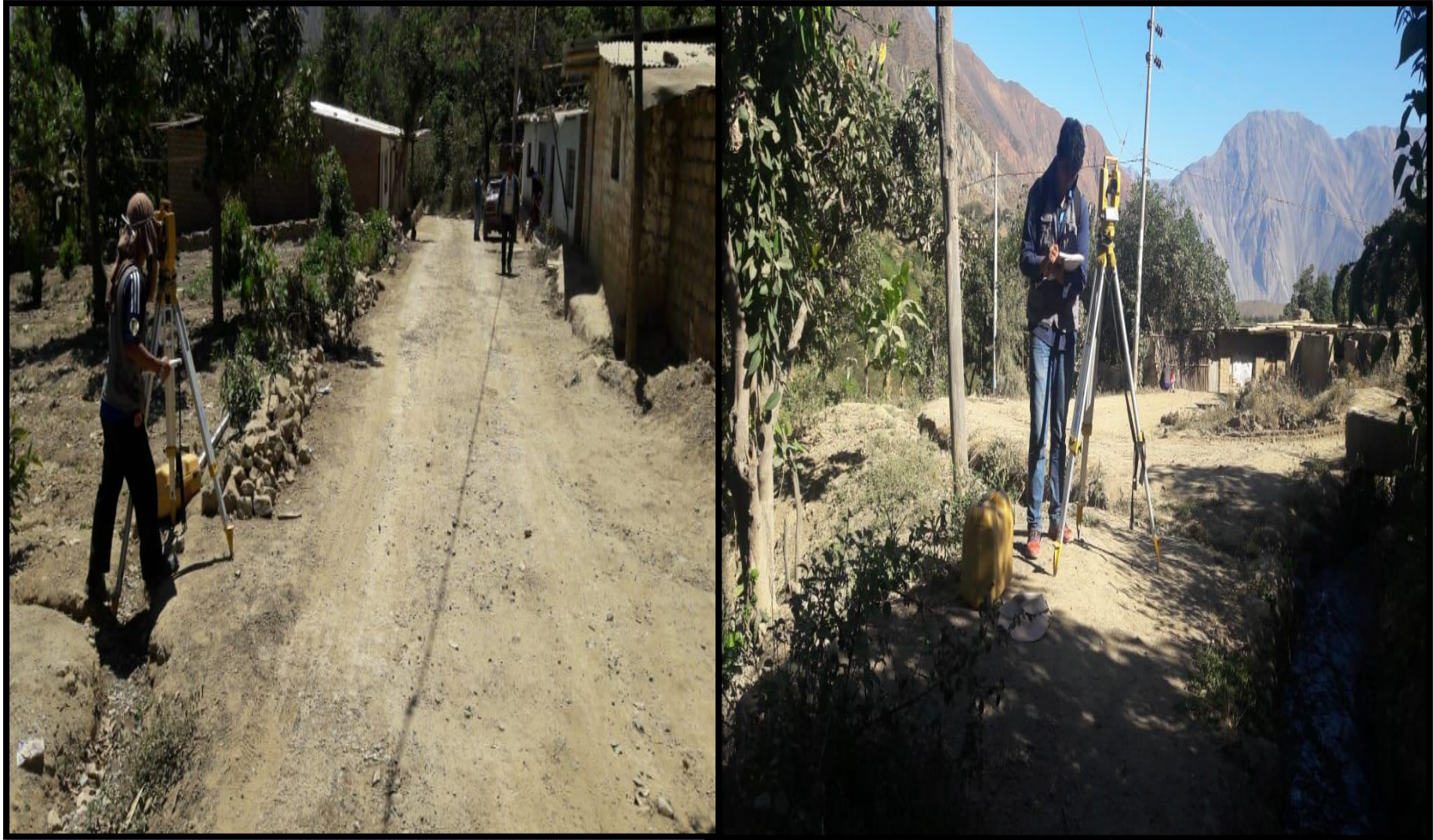
Figura 28, Figura 29: Fotografía Realizando el levantamiento topográfico donde se proyectó la línea de aducción y red de distribución.
