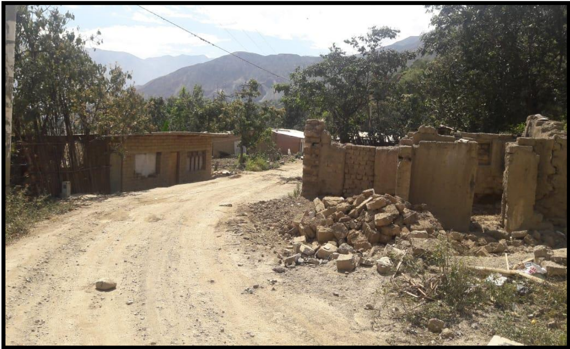
Figura 16 Fotografía donde se proyectó la línea de aducción hasta la primera vivienda. Fuente: Elaboración propia 2022.
