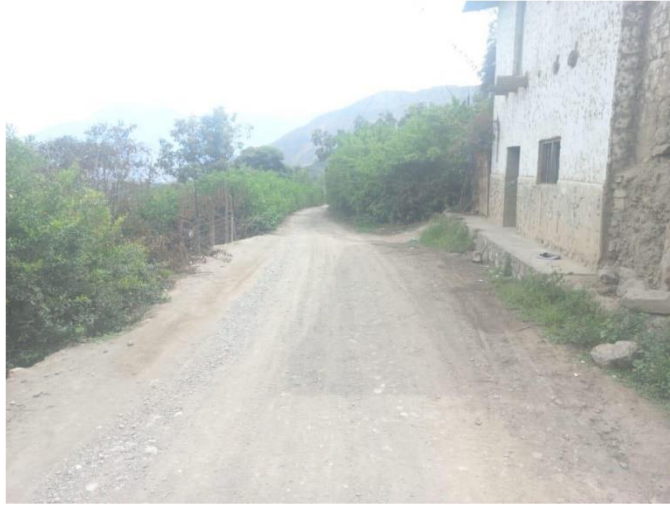
VISTA PANORAMICA DONDE SE PROYECTO LA RED DE DISTRIBUCION Y RED COLECTORA - CASERIO QUIHUAY
