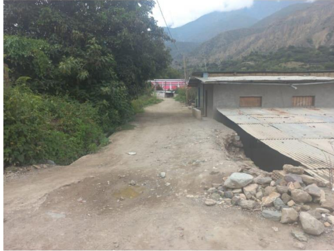
VISTA PANORAMICA DE LA CALICATA DONDE SE PROYECTO LA RED DE DISTRIBUCION Y RED COLECTORA CASERIO QUIHUAY
