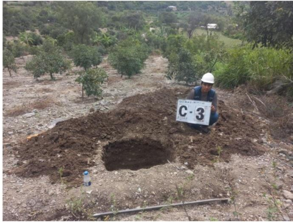
VISTA PANORAMICA DE LA CALICATA C-3 DONDE SE PROYECTO EL RESERVORIO DE ALMACENAMIENTO - CASERIO QUIHUAY
