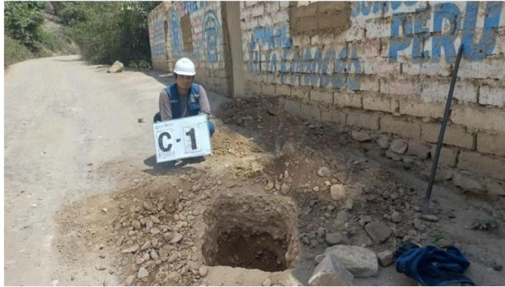
VISTA PANORAMICA DE LA CALICATA C – 1 DONDE SE PROYECTO LA LINEA DE CONDUCCION - CASERIO QUIHUAY.
