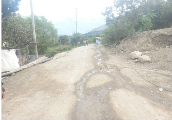
VISTA PANORAMICA DONDE SE PROYECTO LA RED DE DISTRIBUCION Y RED COLECTORA - CASERIO QUIHUAY
