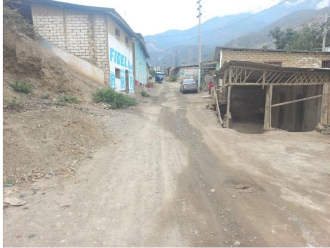
VISTA PANORAMICA DONDE SE PROYECTO LA RED DE DISTRIBUCION Y RED COLECTORA - CASERIO QUIHUAY
