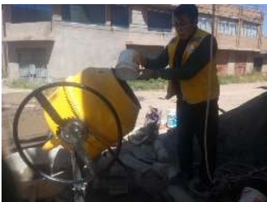
Figura 5: preparación de mezcla de concreto f'c=100\text{Kg}/\text{cm}^2
