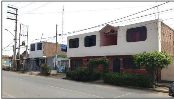
RDM (Residencial Densidad Media) "Viviendas" Calle Micaela Bastidas
