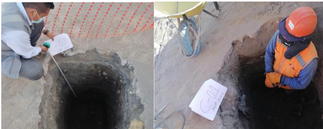
7.- Excavación de calicata c-01
