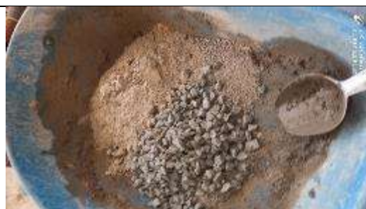
Fotografía 18: Preparación de materiales para mezcla de concreto.
