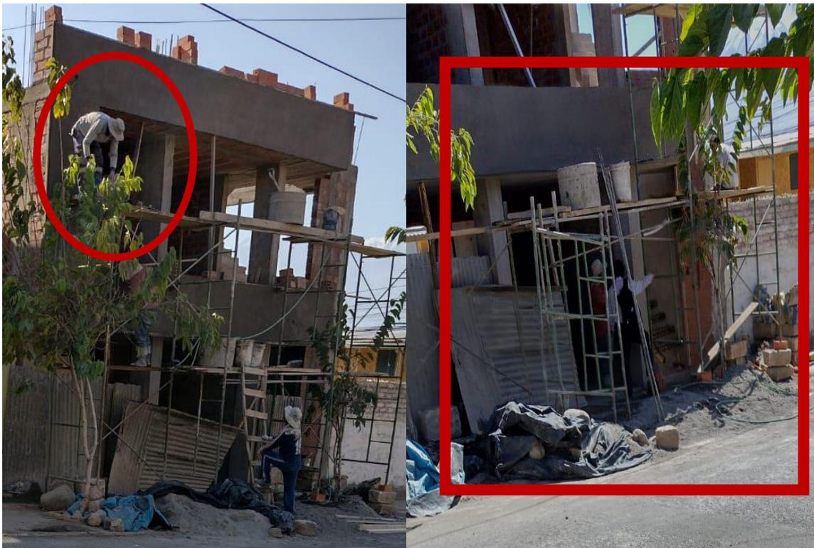
Figura 4. Evidencia de inadecuadas condiciones de trabajo y exposición del trabajador
