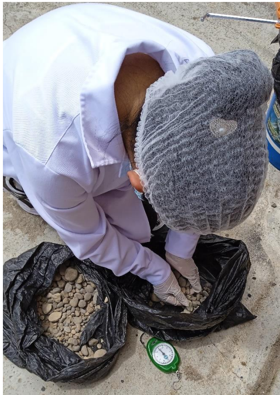
Uso de grava para el acondicionamiento de los filtros.
