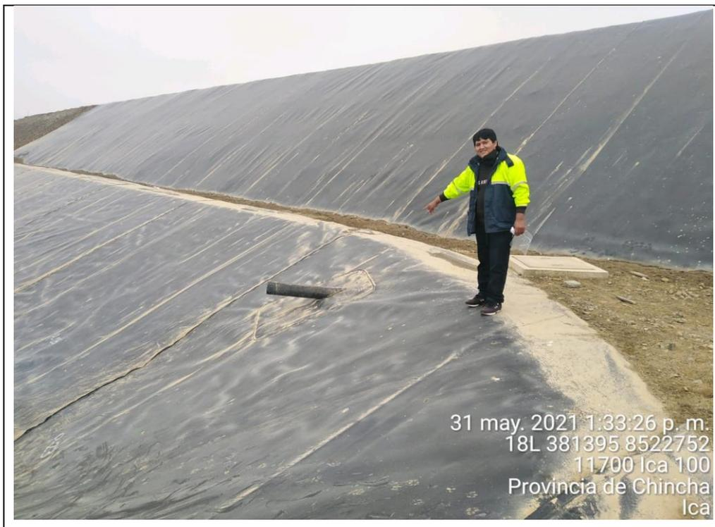
**Figura N° 17:** Punto de muestreo de la tubería del efluente de la poza de lixiviados.
