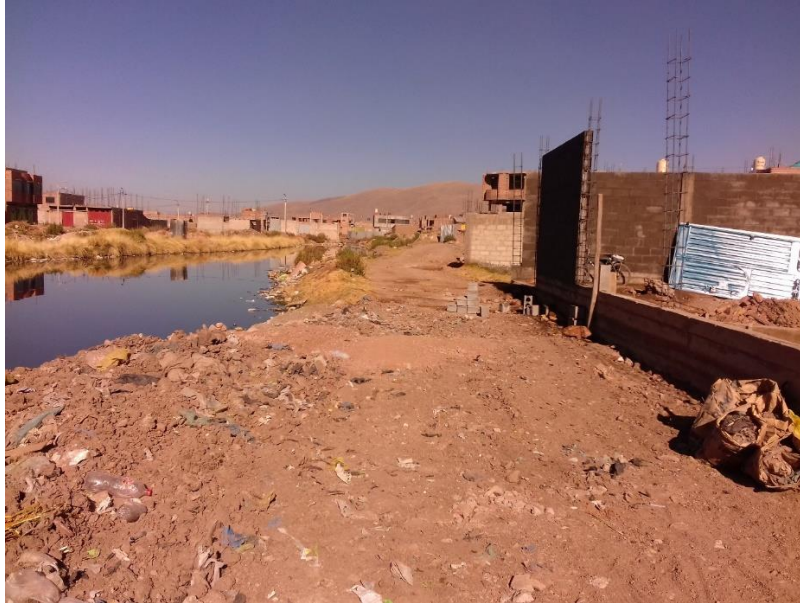
Figura 19. Construcción de vivienda en zonas próximas al río Torococha
