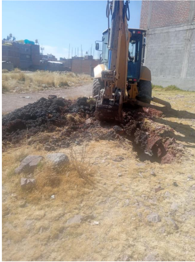
Excavación de zanja para calicata
