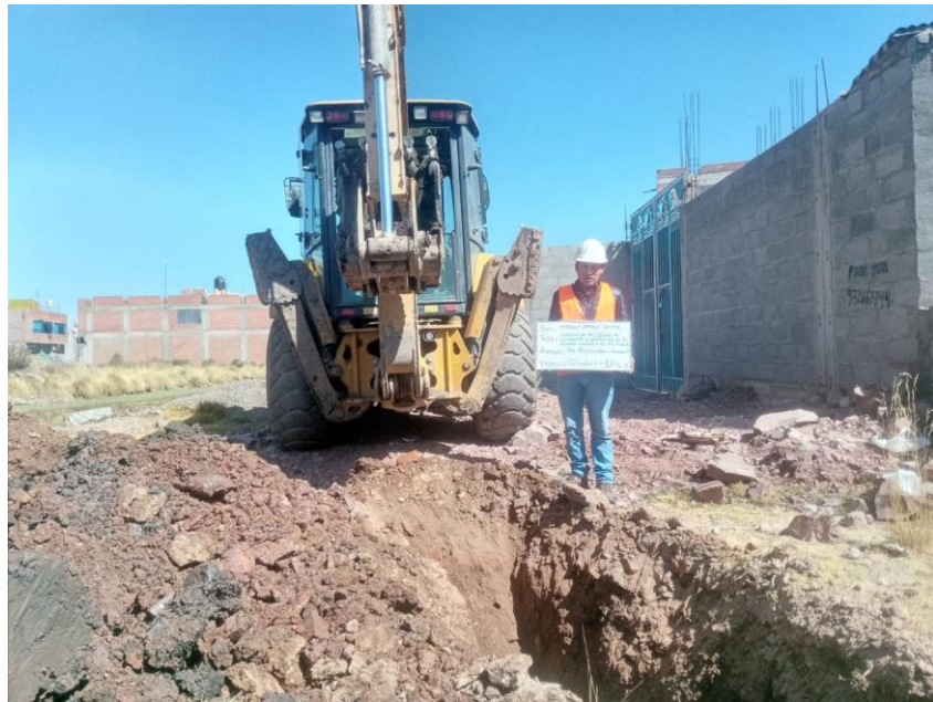
Figura 21. Excavación de calicata con retroexcavadora
