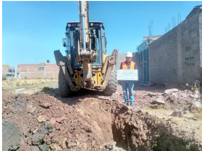
Calicata para ensayo DPL
