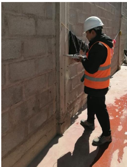
Figura 57. Prueba de esclerómetro en columna – vivienda 02
