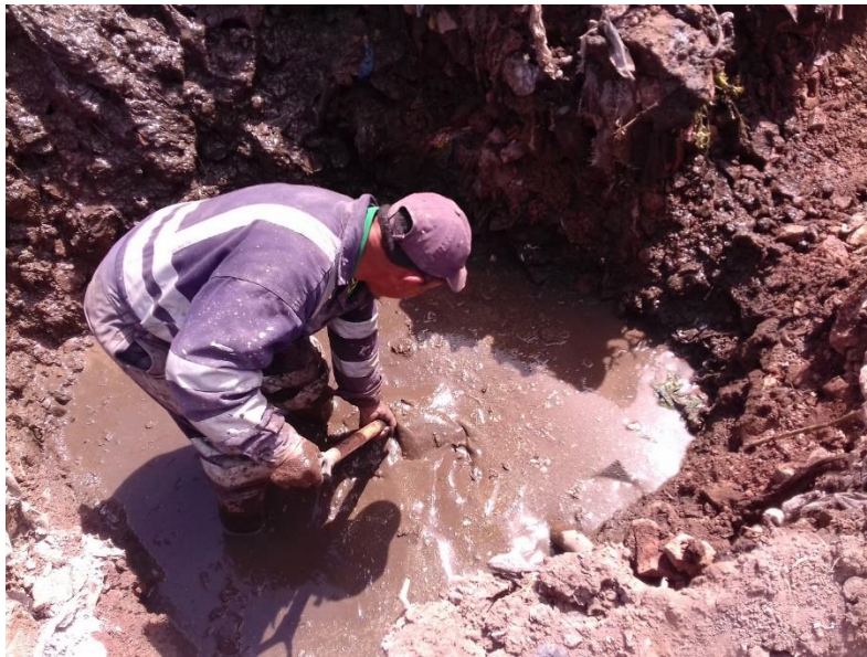
Figura 18. Excavación de zapata aislada
