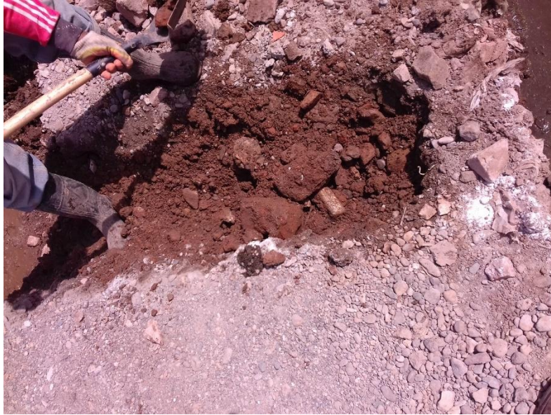
Figura 17. Inicio de excavación se zapata
