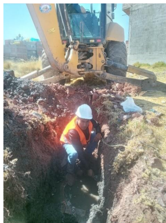
Figura 22. Obtención de muestra de la calicata
