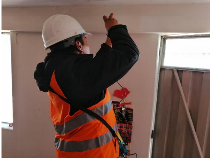
Figura 56. Prueba de esclerómetro en viga – vivienda 01
