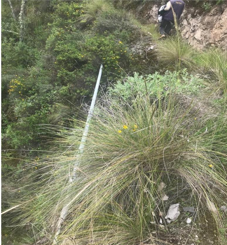
**Fotografía N° 11:** Vista de la tubería galvanizada en la línea de conducción.
