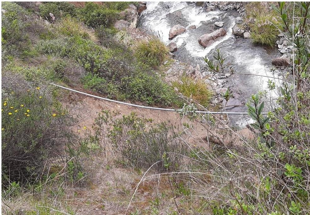
**Fotografía N° 12:** Vista del tramo de la línea de conducción de tubo galvanizado debido al terreno accidentado.
