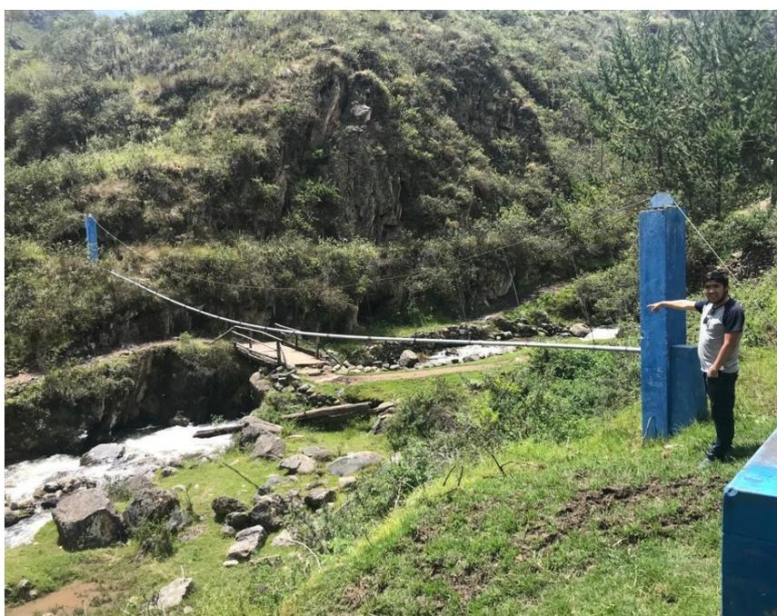
**Fotografía N° 06:** Vista de Traslase de tubo galvanizado del sistema de agua potable de la merced.
