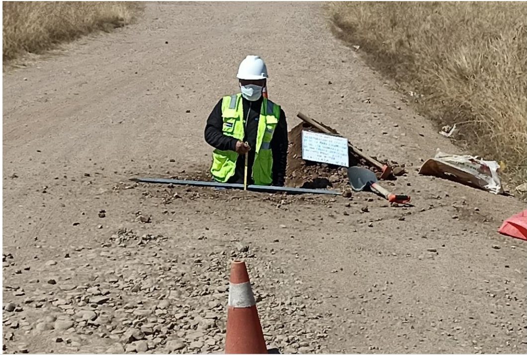
FOTOGRAFIA N° 01: EXCAVACION CALICATA C-1
