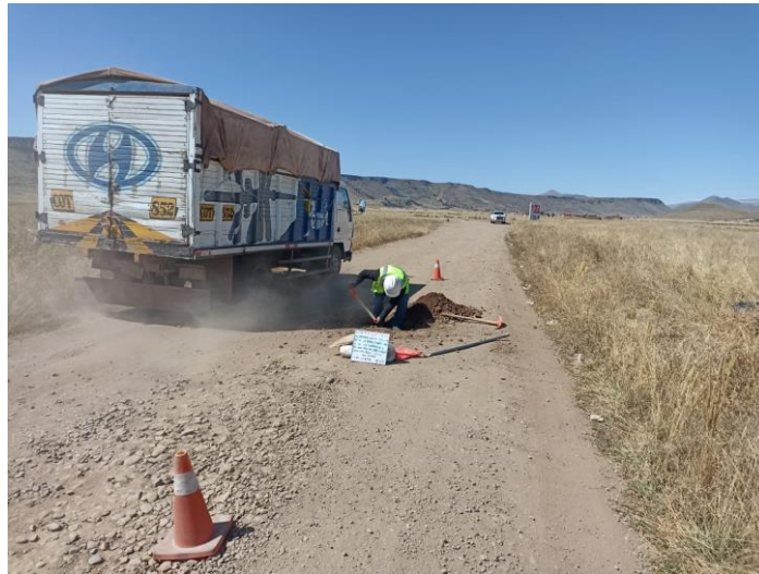
Figura 14. Excavación de la calicata C-1 ubicado en el km 01+950
