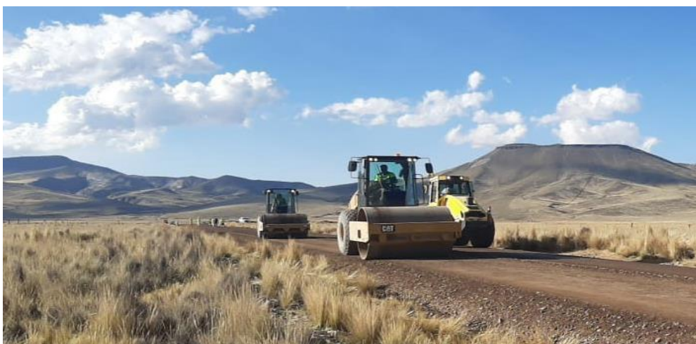
Figura 3. Compactación de suelo con rodillo liso
