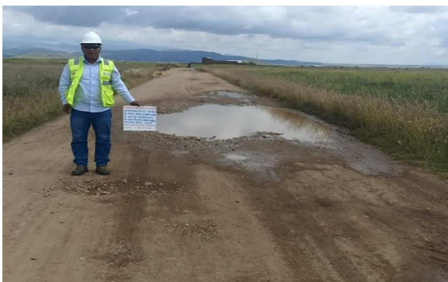
*Figura 1.* Presencia de baches y deterioro de la vía.
