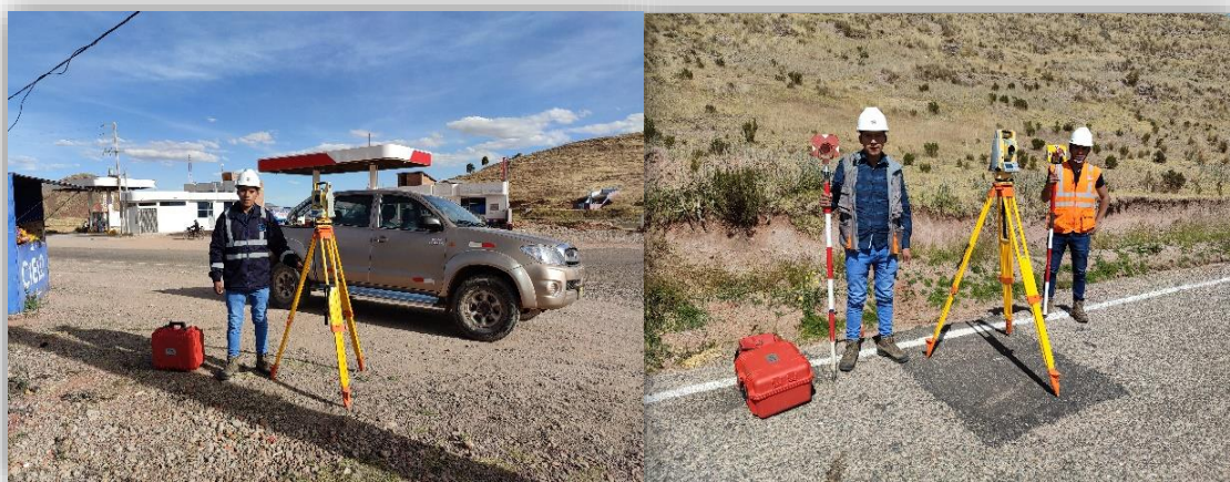
Figura N° 15. Inicio de las lecturas en el levantamiento topográfico.
