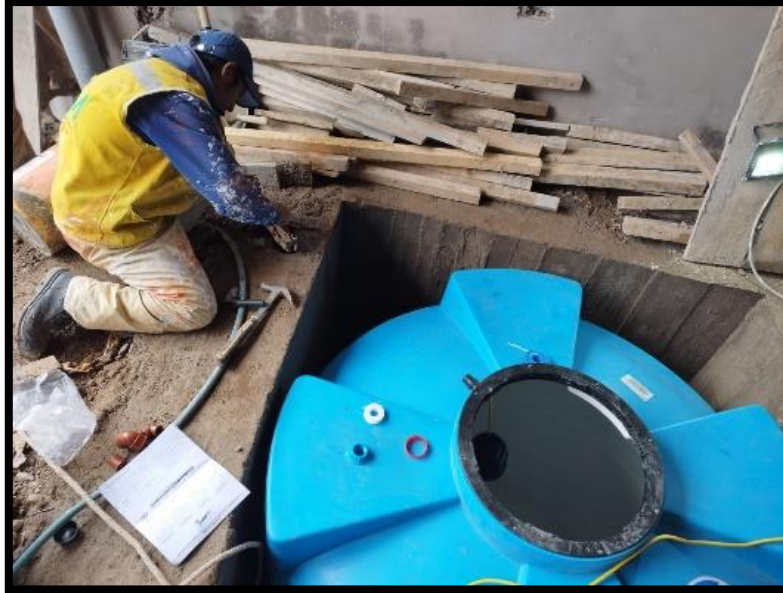
Figura 18: Colocado de cisterna de almacén de agua Fuente: Elaboración propia
