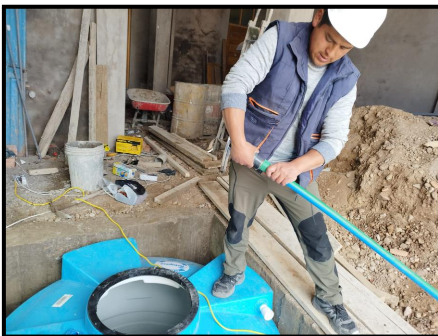
Figura 11: Instalación de cisterna Fuente: Elaboración propia
