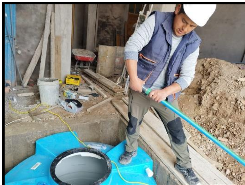
Figura 19: Supervisión de trabajos de instalación de Cisterna de agua. Fuente: Elaboración propia
