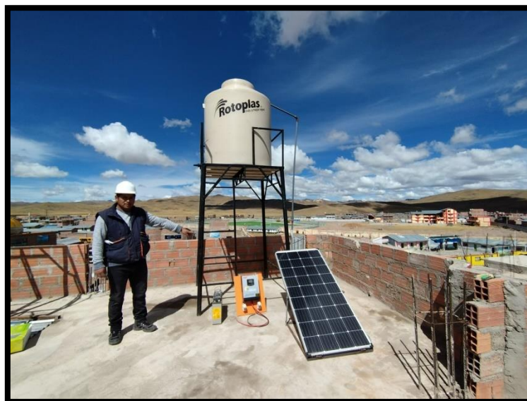
Figura 4: Almacenamiento de agua en tanque elevado Fuente: Elaboración propia
