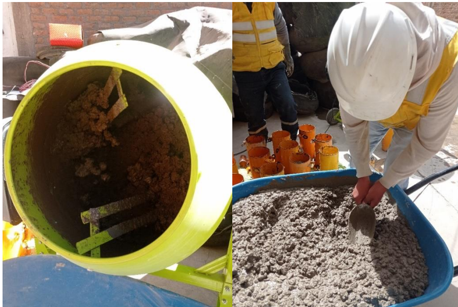
Figura 46. Mezclado del concreto fresco y vertido a bugui para el traslado.
