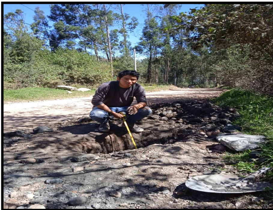
En esta figura se visualiza la excavación de la calicata C-02.
