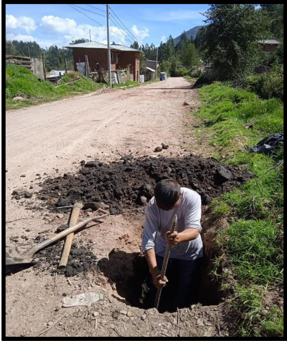
Excavación de la calicata C-01 y se va notando tipo de suelo que se encuentra.
