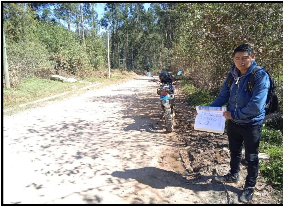
En esta figura se visualiza la ubicación de la calicata C-02 en la progresiva 0+500.
