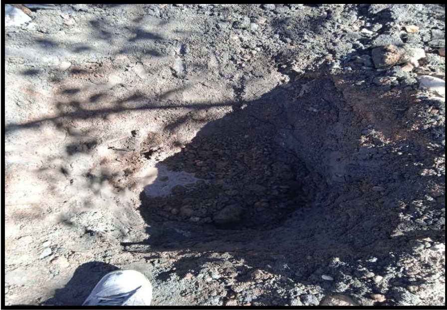
En la figura se visualiza la afloración del agua subterránea en una profundidad de 1.30 m
