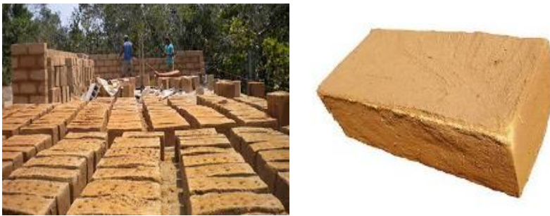
Figura N° 2: Elaboración de adobe y Unidad de adobe.
