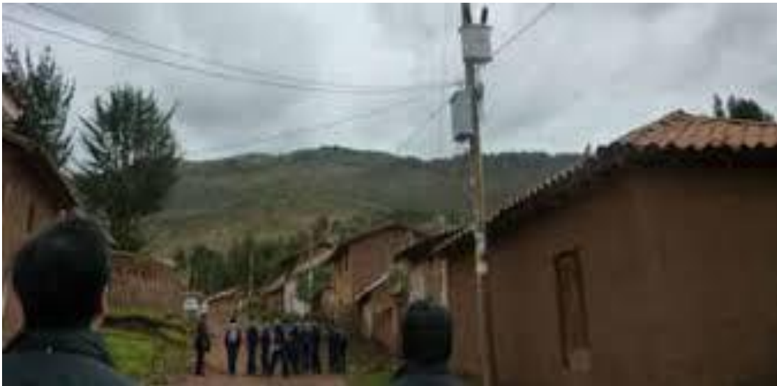
FIGURA 5. Servicio de energía
