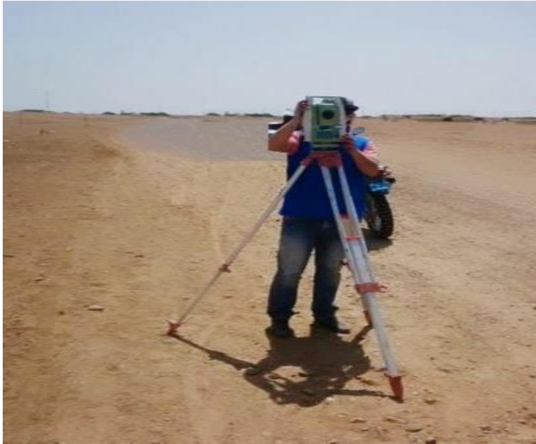
Figura 1. Instalación de la Estación Total
