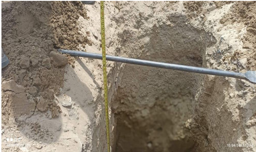
Foto N° 07: Medición de la excavación de la C-3
