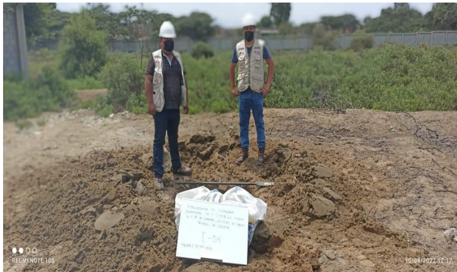
Foto N° 10: Excavación de la C-4
