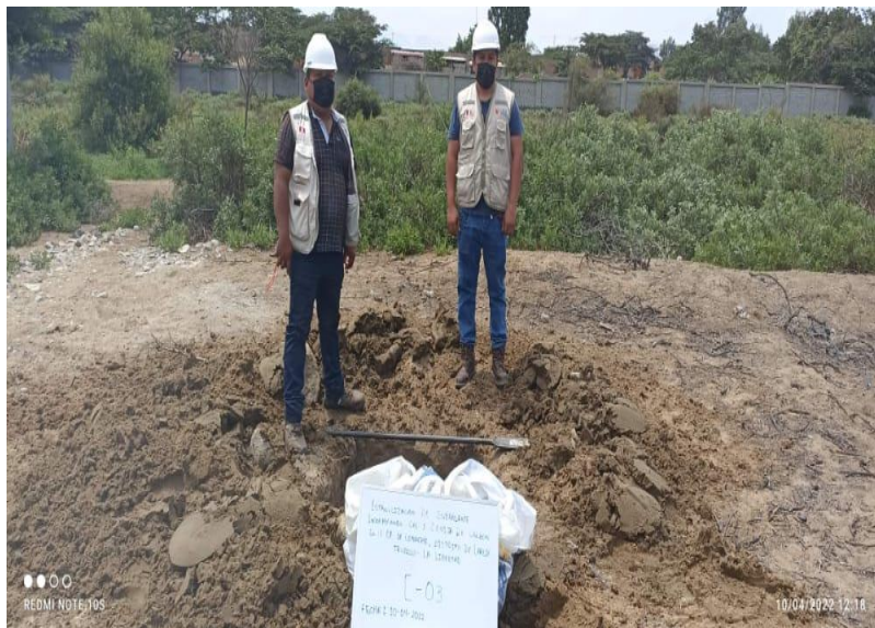
Foto N° 08: Excavación de la C-3
