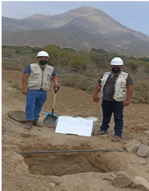
Foto N° 03: Excavación de la C-1
