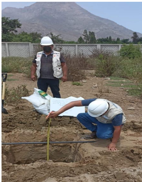
Foto N° 04: Medición de la excavación de la C-2
