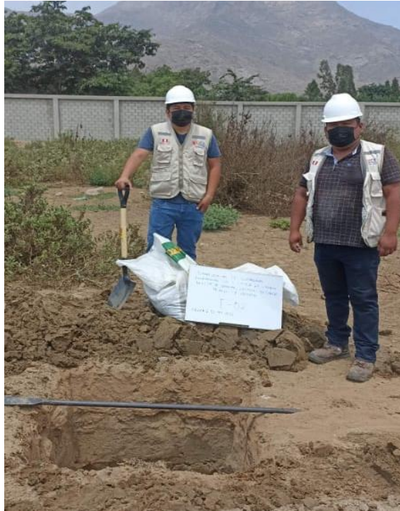
Foto N° 05: Excavación de la C-2
