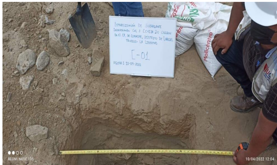
Foto N° 02: Medición de la excavación de la C-1
