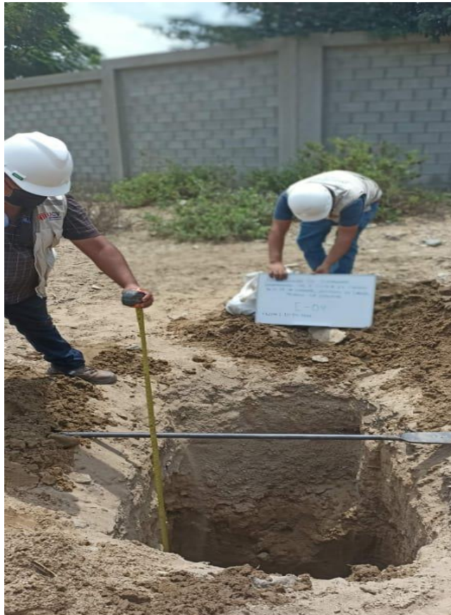
Foto N° 09: Medición de la excavación de la C-4
