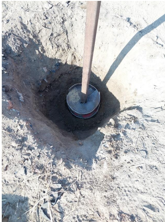
Excavación de la calicata C-1
