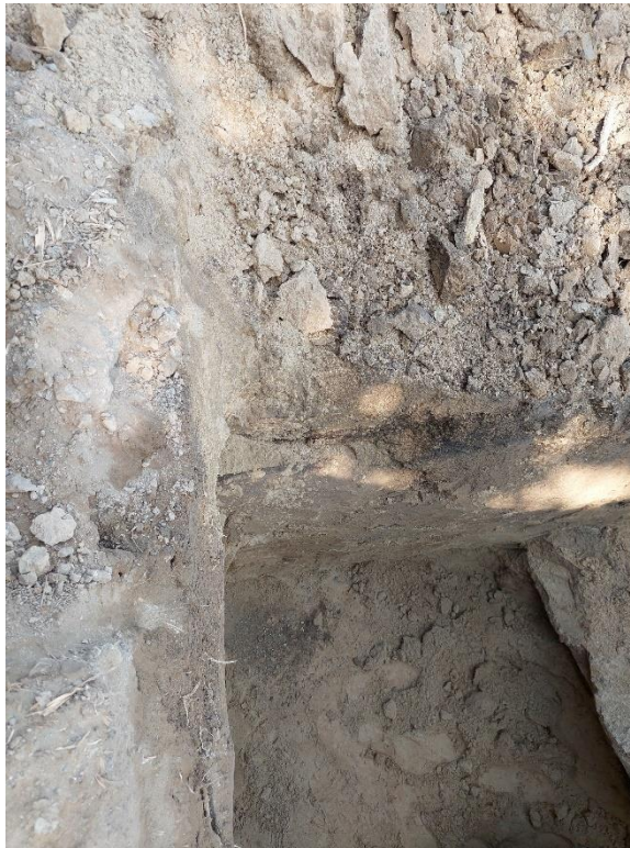
Excavación de la calicata C-2
