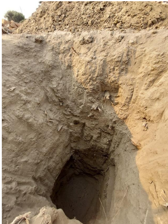
Calicata C-1 a 1.50m de profundidad
