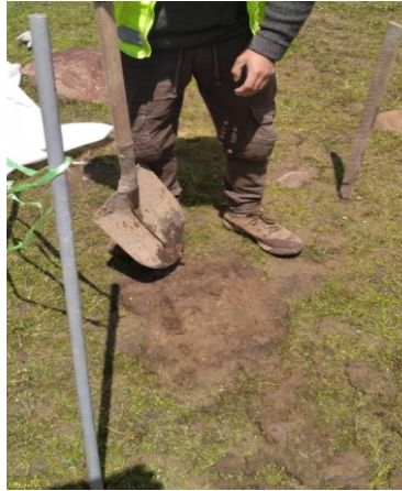
Figura 5. Limpieza la parte superficial del suelo (vegetación y piedras)
