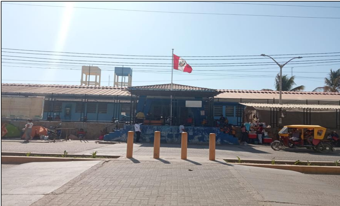
Hospital Público de Sullana
