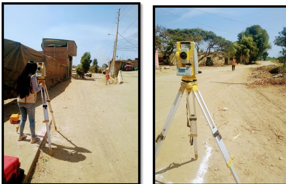
Figura 4. Toma de datos para la poligonal con estación total.
