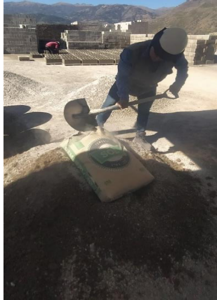
Figura 7. Dosificación de la mezcla f'c=210\text{kg/cm}^2 .
