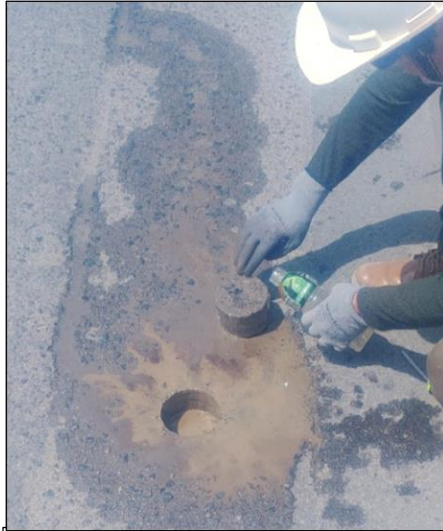
Imagen 09: Extracción de muestras falla 03 Prog. Km. 2+730
