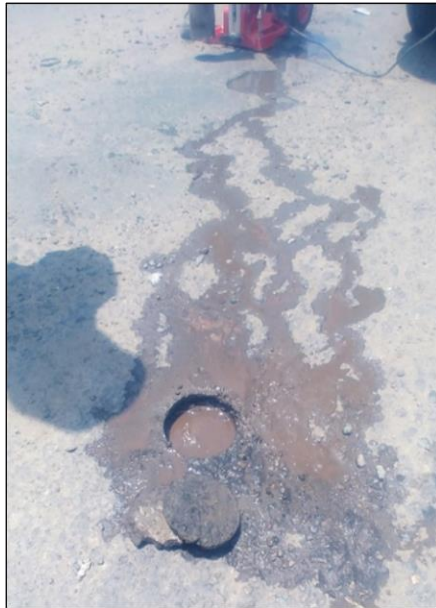
Imagen 10: Extracción de muestras falla 04 Prog. Km. 3+620
