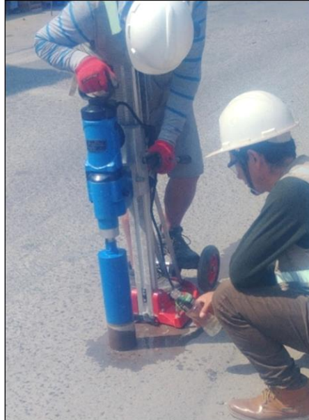
Imagen 07: Penetración de carpeta asfáltica falla 02 Prog. Km. 1+900
