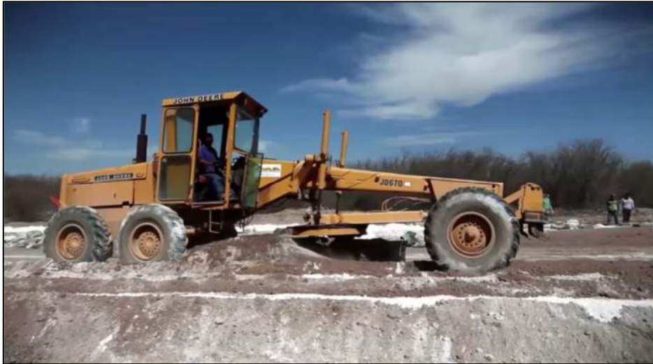
Imagen 5. Estabilización con cal. Tomada de “Estabilización de suelos arcillosos con cal”, de Horcalsa. 2020.
