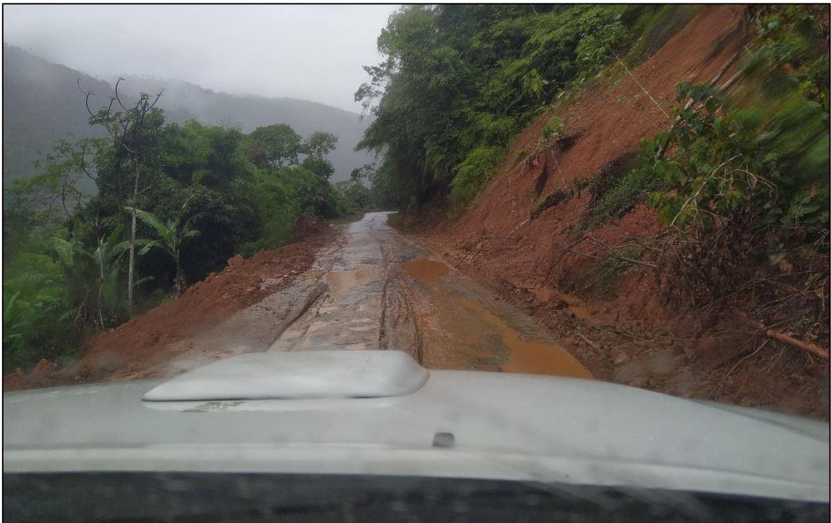
Fotografía 11. Se puede observar que se tiene bastante inestabilidad para realizar el recorrido del camino, ya que en temporadas de lluvias la vía se hace intransitable.
