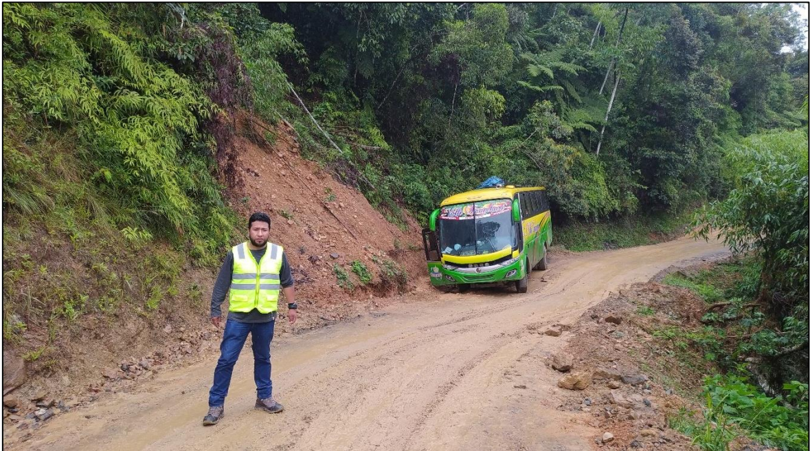
Fotografía 09. Se observa una superficie deslizante por lo que los vehículos pierden la estabilidad y son arrastrados a la cuneta, esto se da por el material con el que se conforma la vía, esto por ser un suelo arcilloso.
