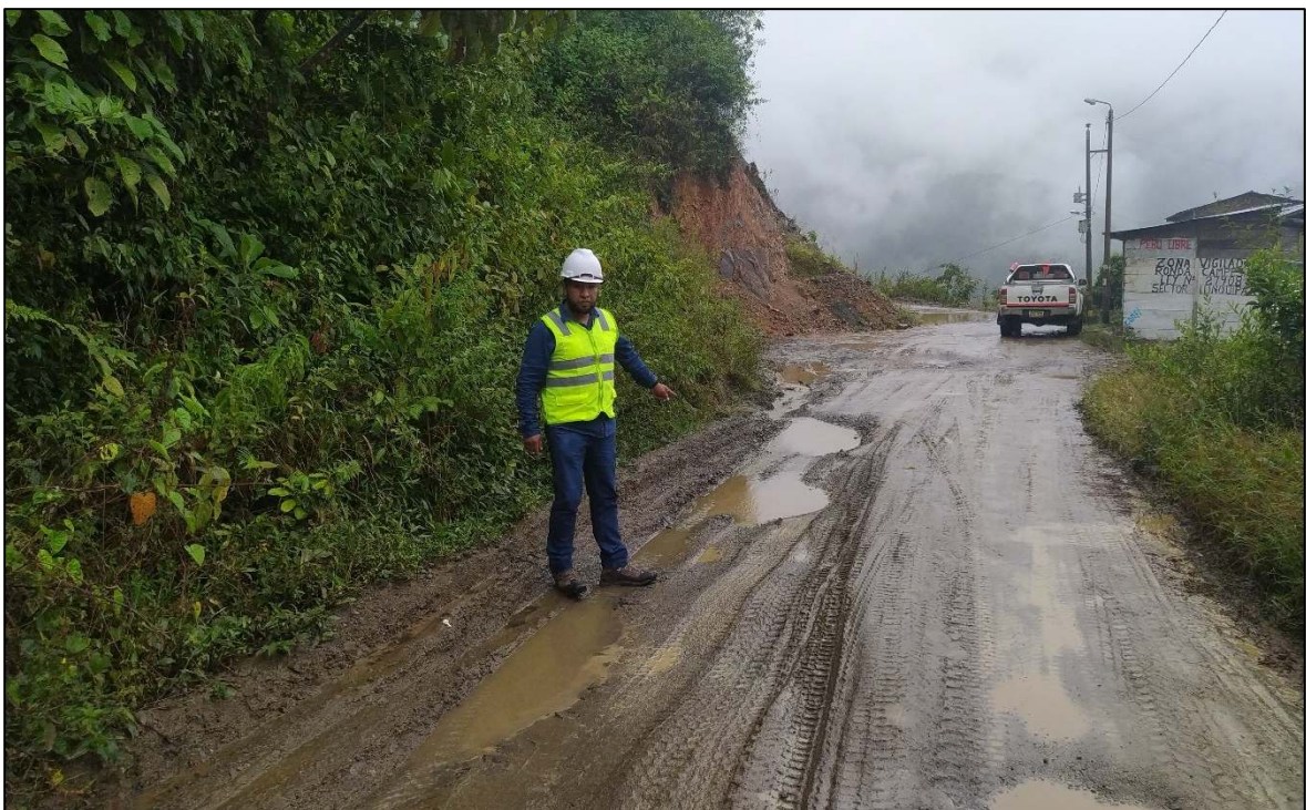
Imagen 3. Ahuellamientos y acumulación de agua en la vía.
