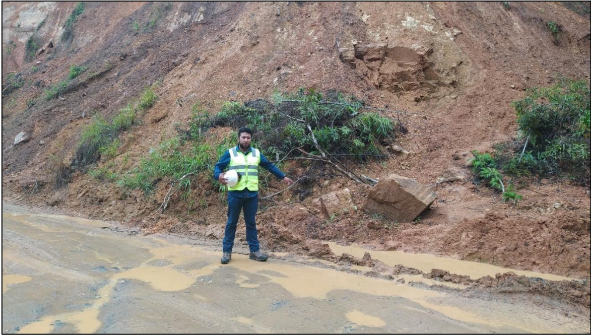
Fotografía 04. Se puede apreciar las características del material que se presenta en el derrumbe, esto se da por las fuertes precipitaciones pluviales y la inestabilidad que presenta dicho material.
