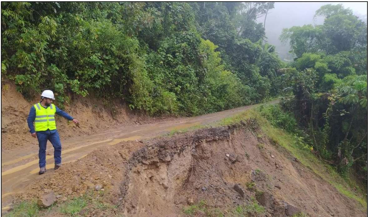
Fotografía 07. Se observa la pérdida de plataforma causada por la filtración de agua en la vía.
