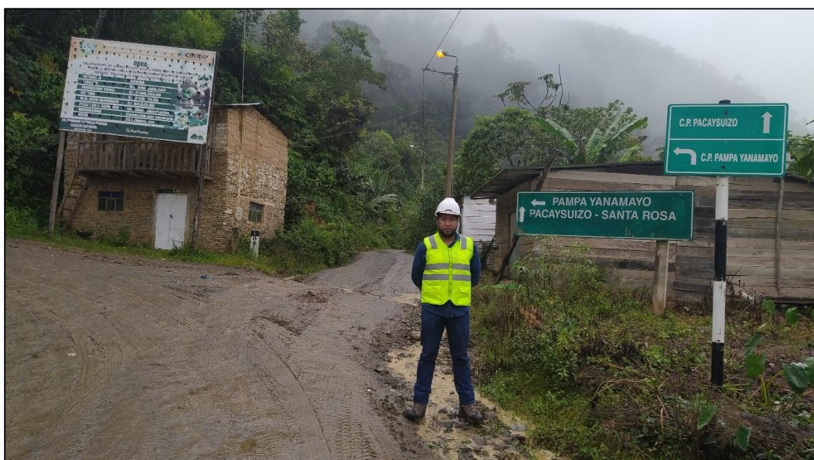
Fotografía 03. Se tiene el inicio del camino vecinal Santiago Pampa, en donde se podrá apreciar el mal estado de la vía, todo esto causado por las fuertes precipitaciones pluviales de la zona.
