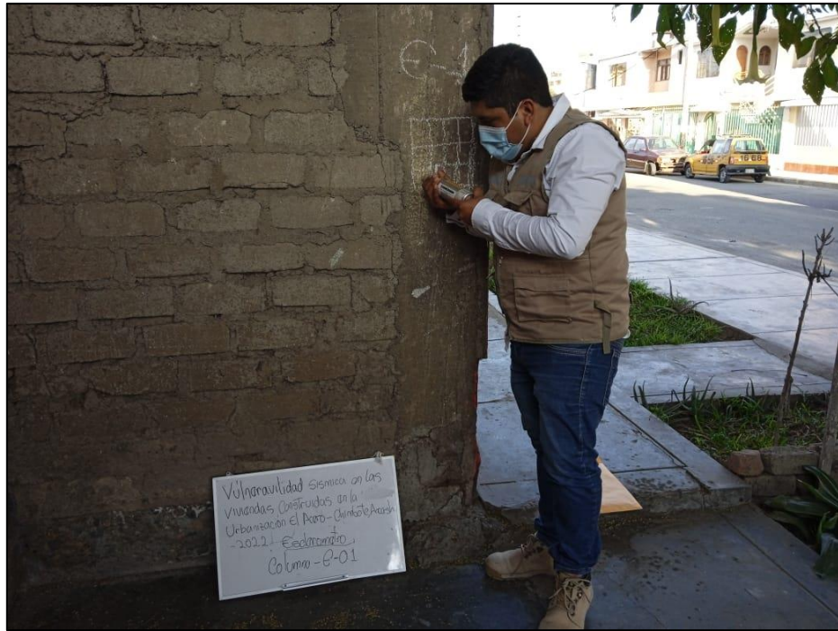
Figura 54. Se muestra prueba de Esclerometría en Columnas Tomado de Elaboración Propia.
