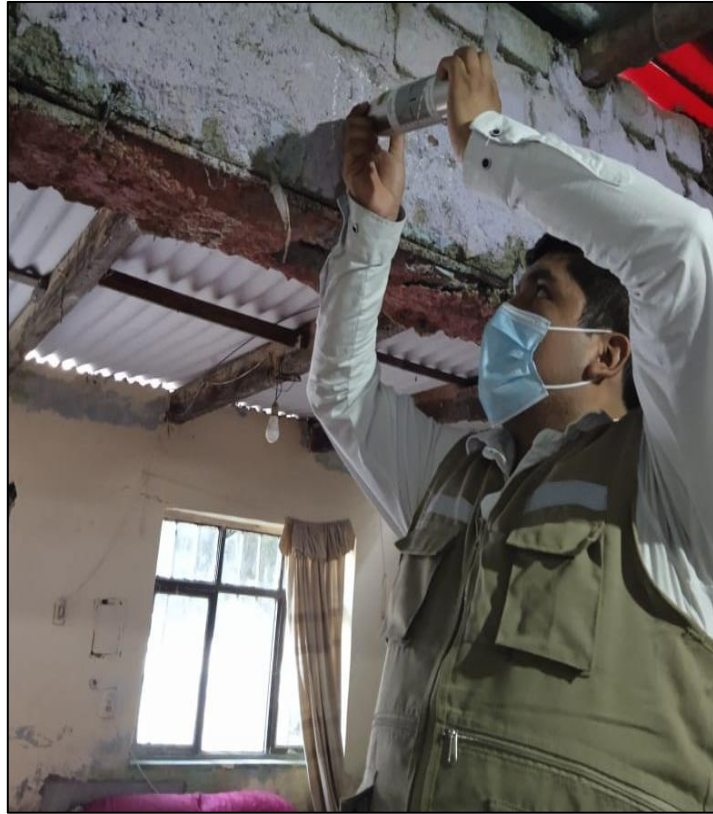
Figura 50. Se muestra prueba de Esclerometría en vigas Tomado de Elaboración Propia.
