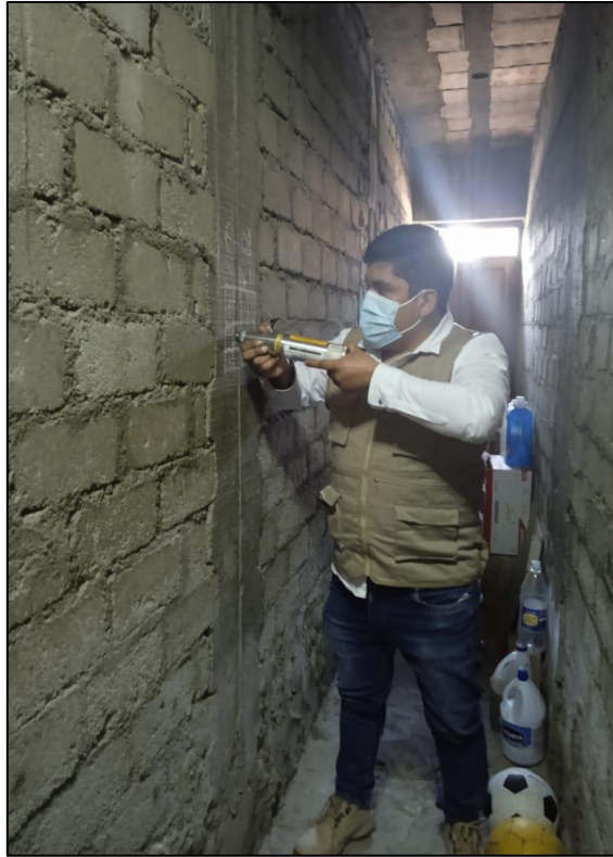
Figura 52. Se muestra prueba de Esclerometría en Columnas Tomado de Elaboración Propia.
