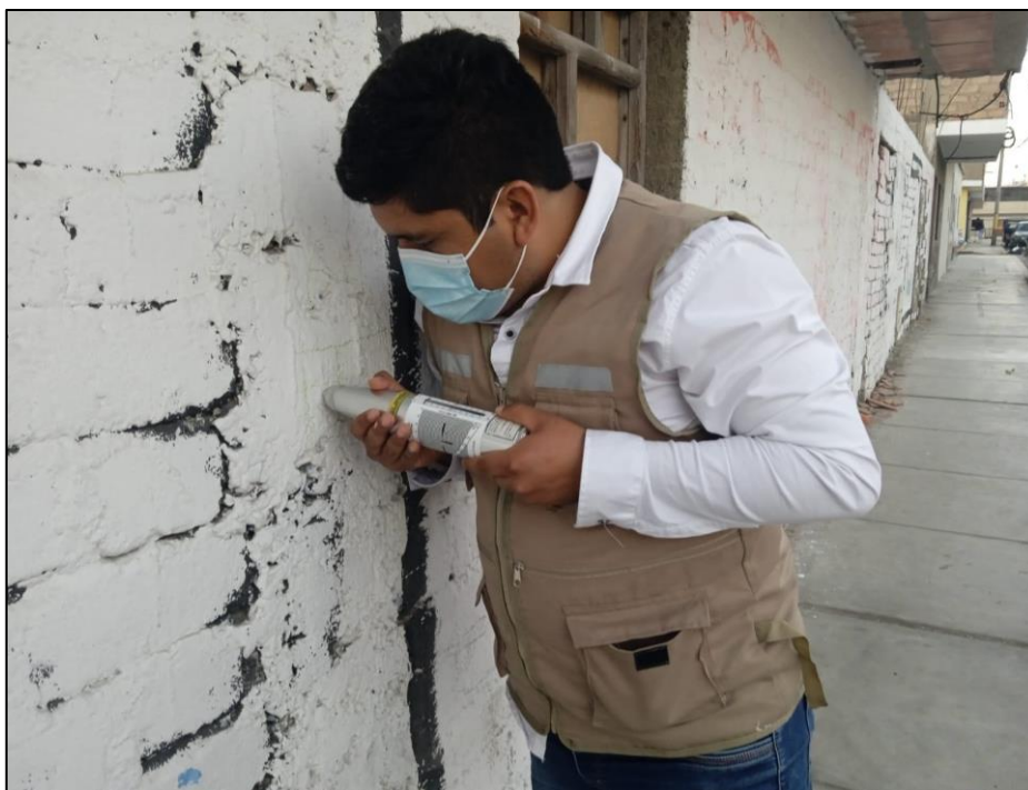
Figura 48. Se muestra la prueba de esclerometría en columna. Tomado de Elaboración Propia.
