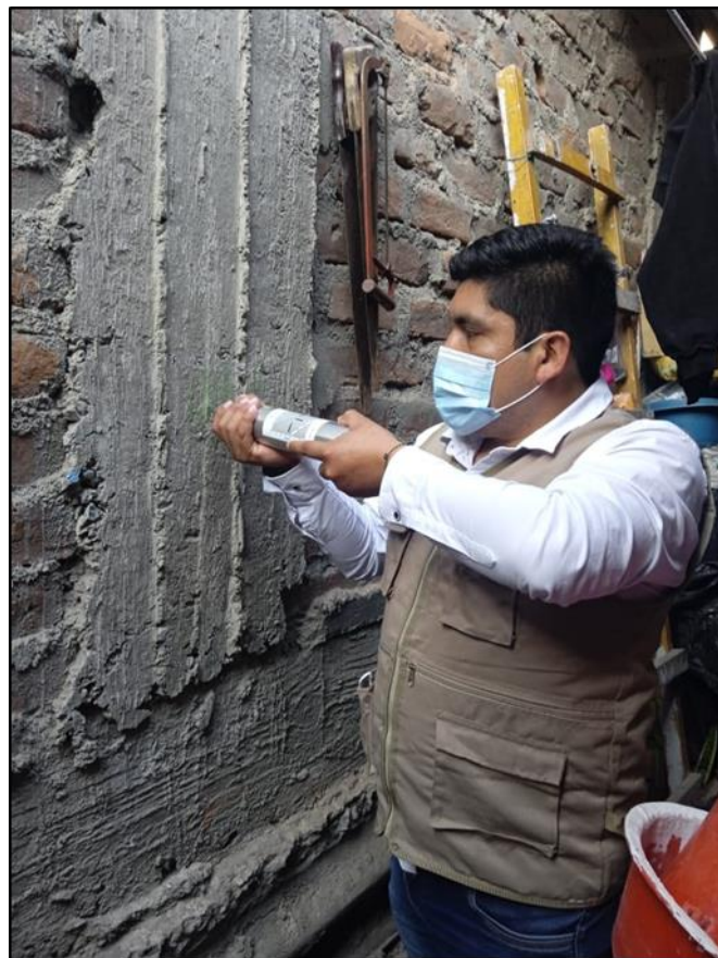
Figura 55. Se muestra prueba de Esclerometría en Columnas Tomado de Elaboración Propia.
