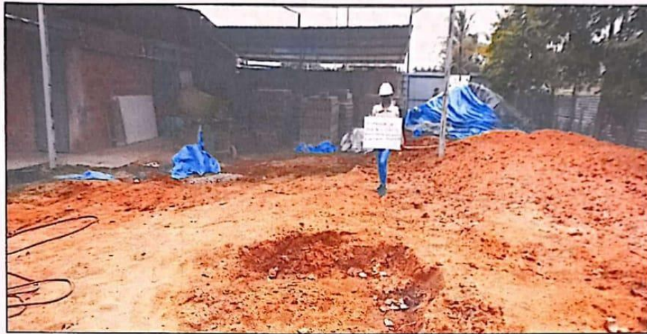
Proceso de explotación del material, arcilla de alta plasticidad (CH) para la elaboración de ladrillos de arcilla, ladrillera SALVADOR, en el distrito de Calzada, provincia de Moyobamba.
