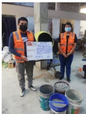
Figura 6. Elaboración de la mezcla de concreto
