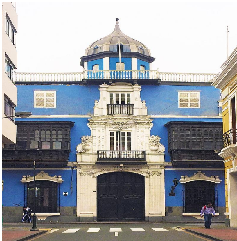
Fachada de la Casona de Osambela
