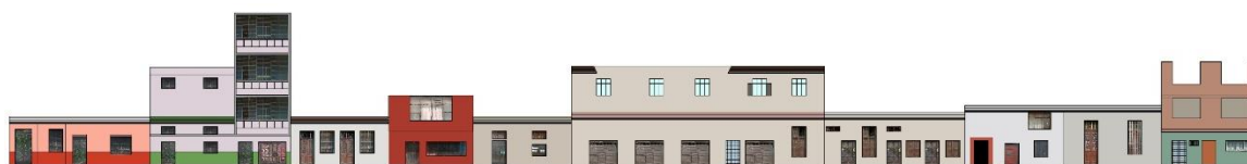
Vista mirando hacia la calle Manuel Pardo
