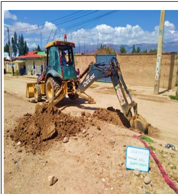
Excavación de C-1 de la progresiva 0+210
