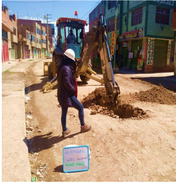
Excavación de C-2 de la progresiva 0+360
