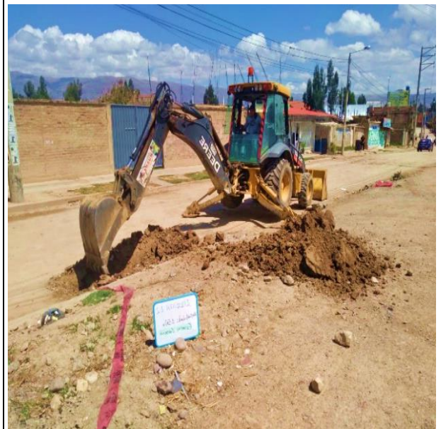
Excavación de C-2 de la progresiva 0+360
