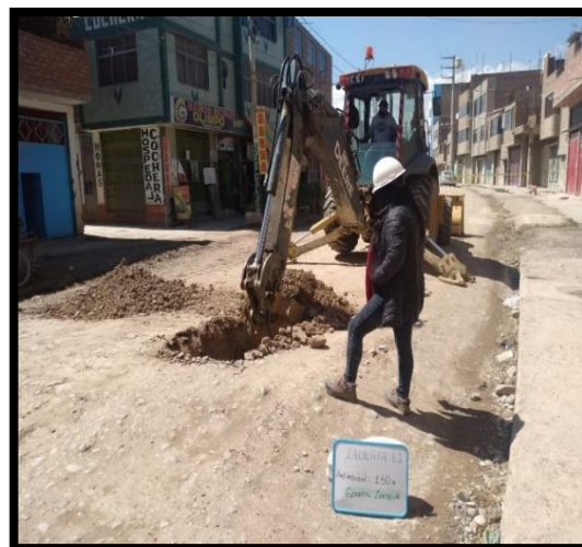
Figura 4 Excavación de calicatas de la Av. General Córdova.
