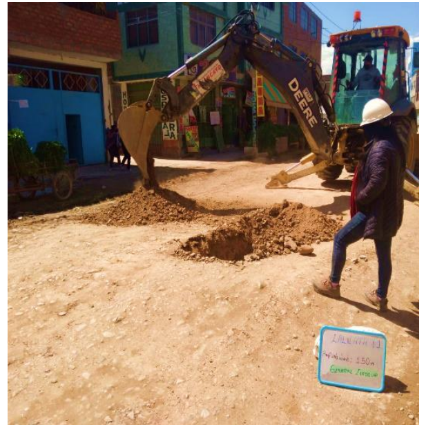
Excavación de C-1 de la progresiva 0+210
