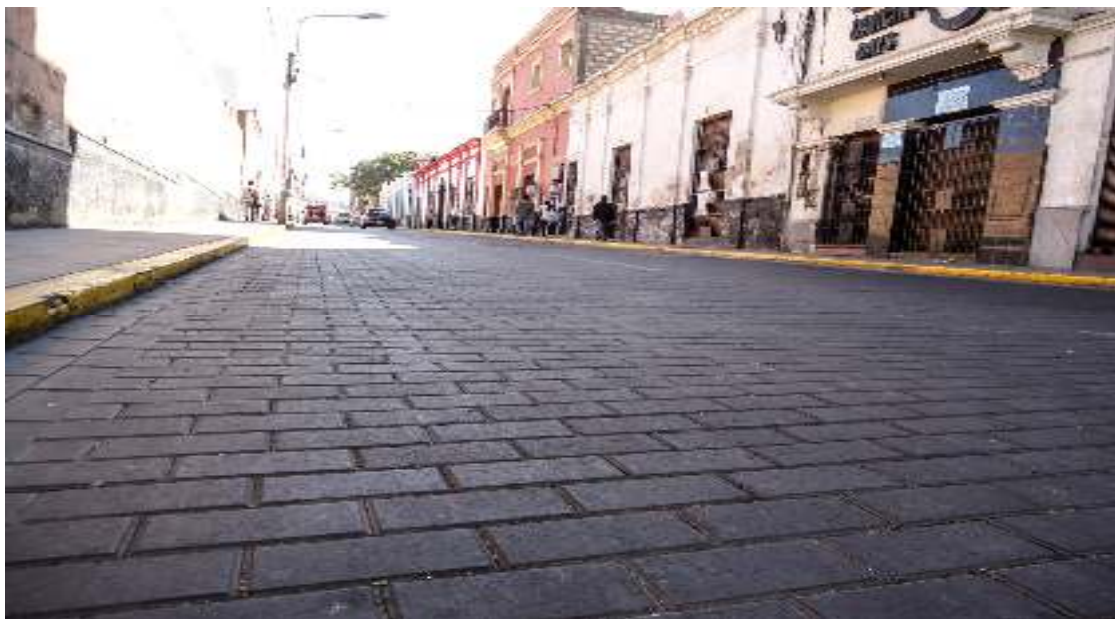
Figura 1: Pavimentación con adoquines
