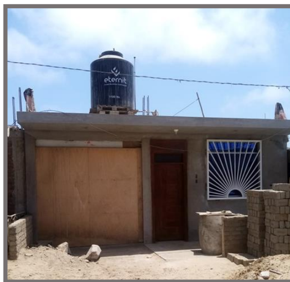
Figura 07: Vivienda con falta de agua potable y alcantarillado.
