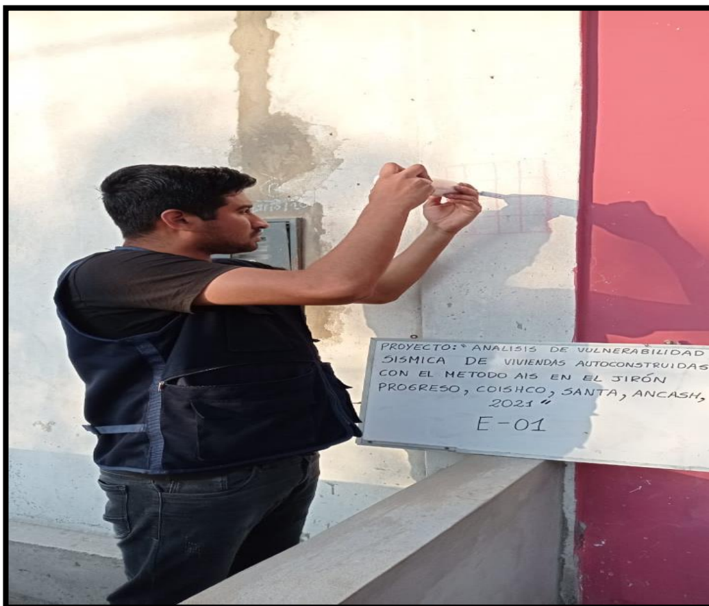
Ensayo no destructivo de esclerometría E-01
