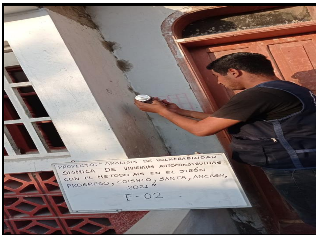
Ensayo no destructivo de esclerometría E-02
