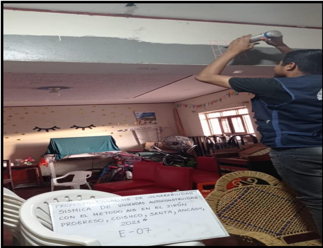
Ensayo no destructivo de esclerometría E-07
