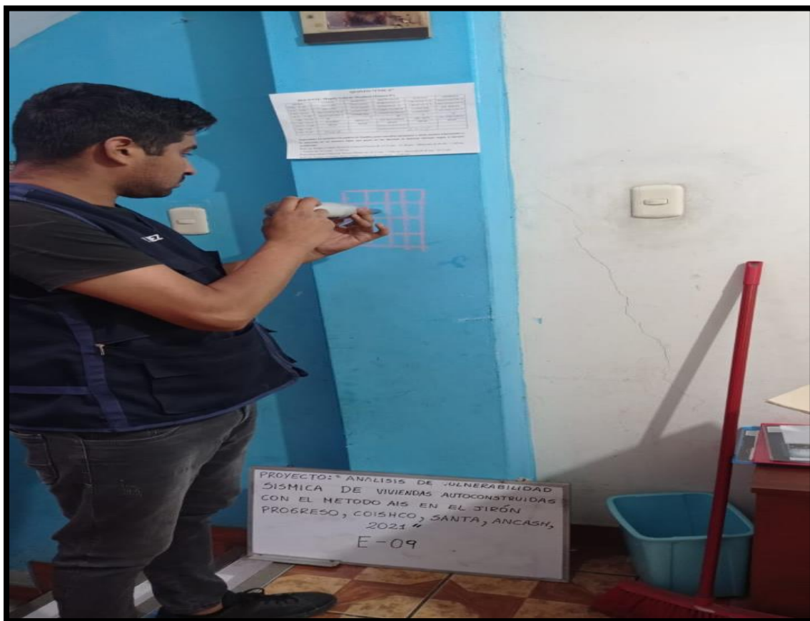
Ensayo no destructivo de esclerometría E-09
