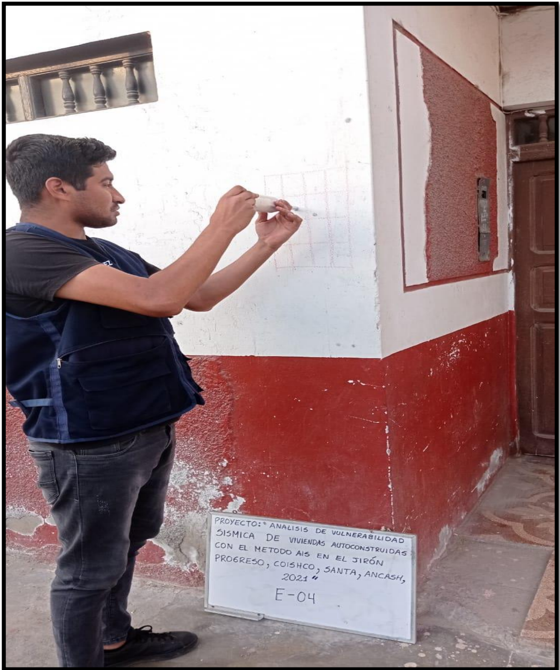
Ensayo no destructivo de esclerometría E-04
