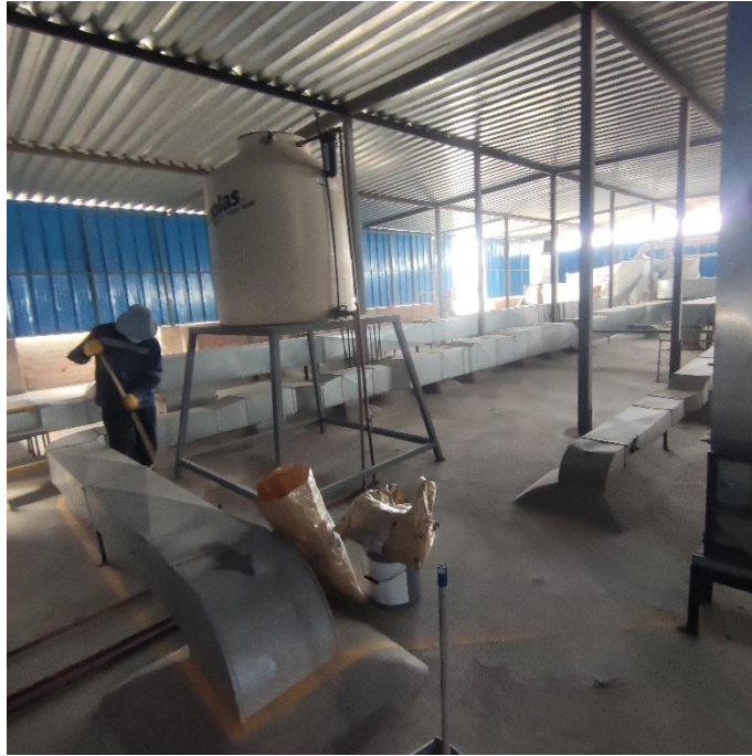
Figura 20. Proceso de limpieza de los pisos técnicos
