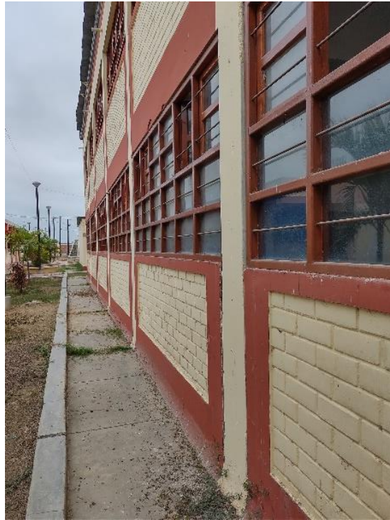
Figura 5. Ventanas, columnas y muros
