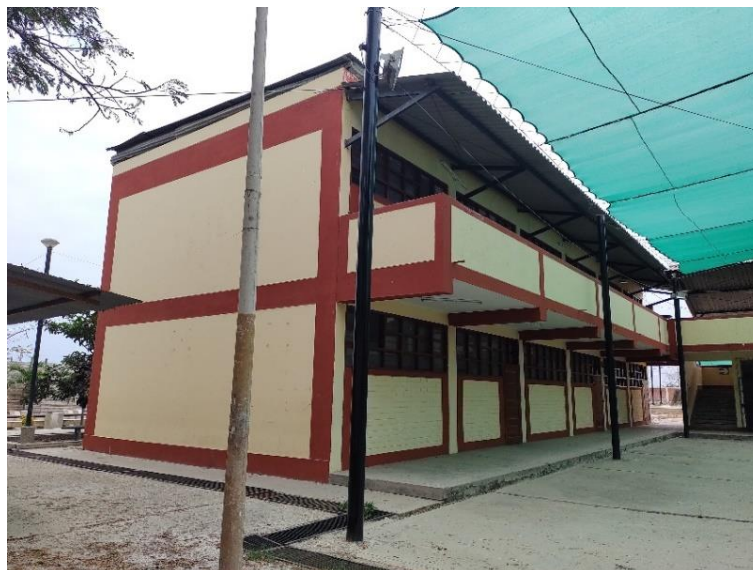
Figura 3. Pabellón N° 01 de la I.E. República del Perú
