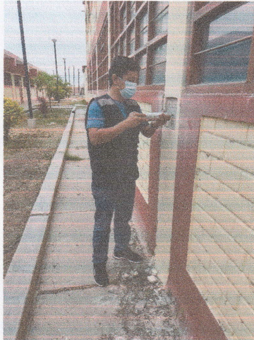
Fotografía N° 01: Ensayo de Esclerometría en Columna C-2 del Pabellón N° 01 del colegio Republica del Perú
