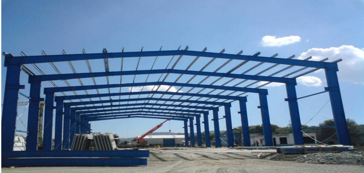
Figura 4. Fotografía de estructura metálica de nave industrial.
