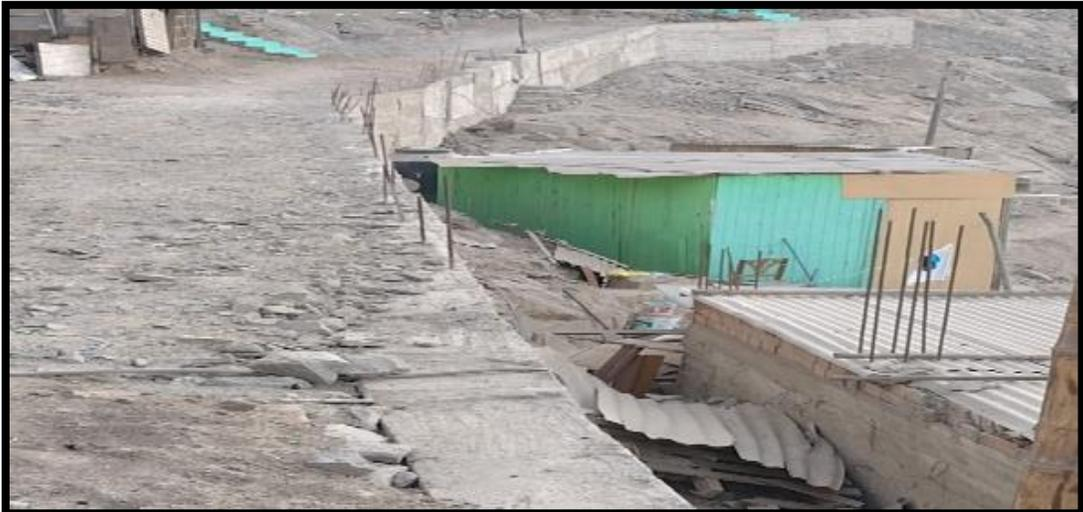
Imagen 3. Problemática sobre muros de contención en mal estado, Santa Clara -Ate
